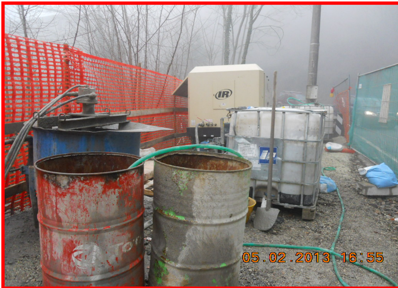
Le attrezzature necessarie per la realizzazione dei micropali a valle della strada
