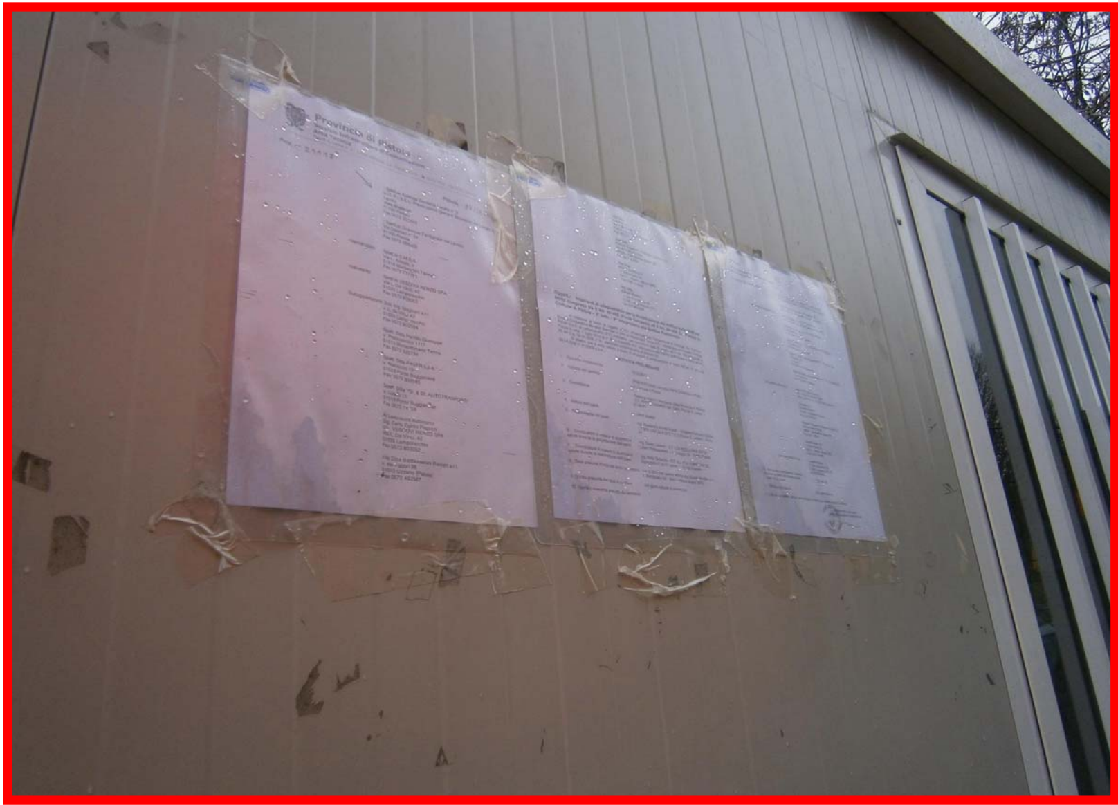
La notifica preliminare affissa sul box di cantiere
