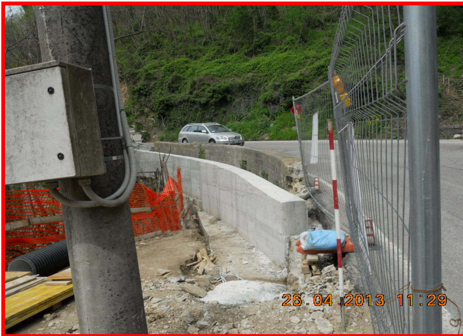
Il muro sul lato valle della strada dopo il disarmo
