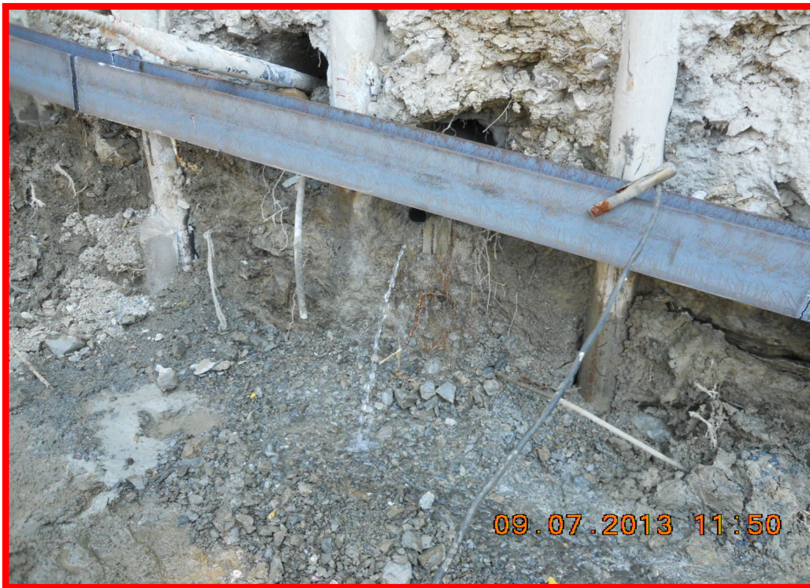
Particolare del profilato in acciaio per il collegamento delle teste dei tiranti
