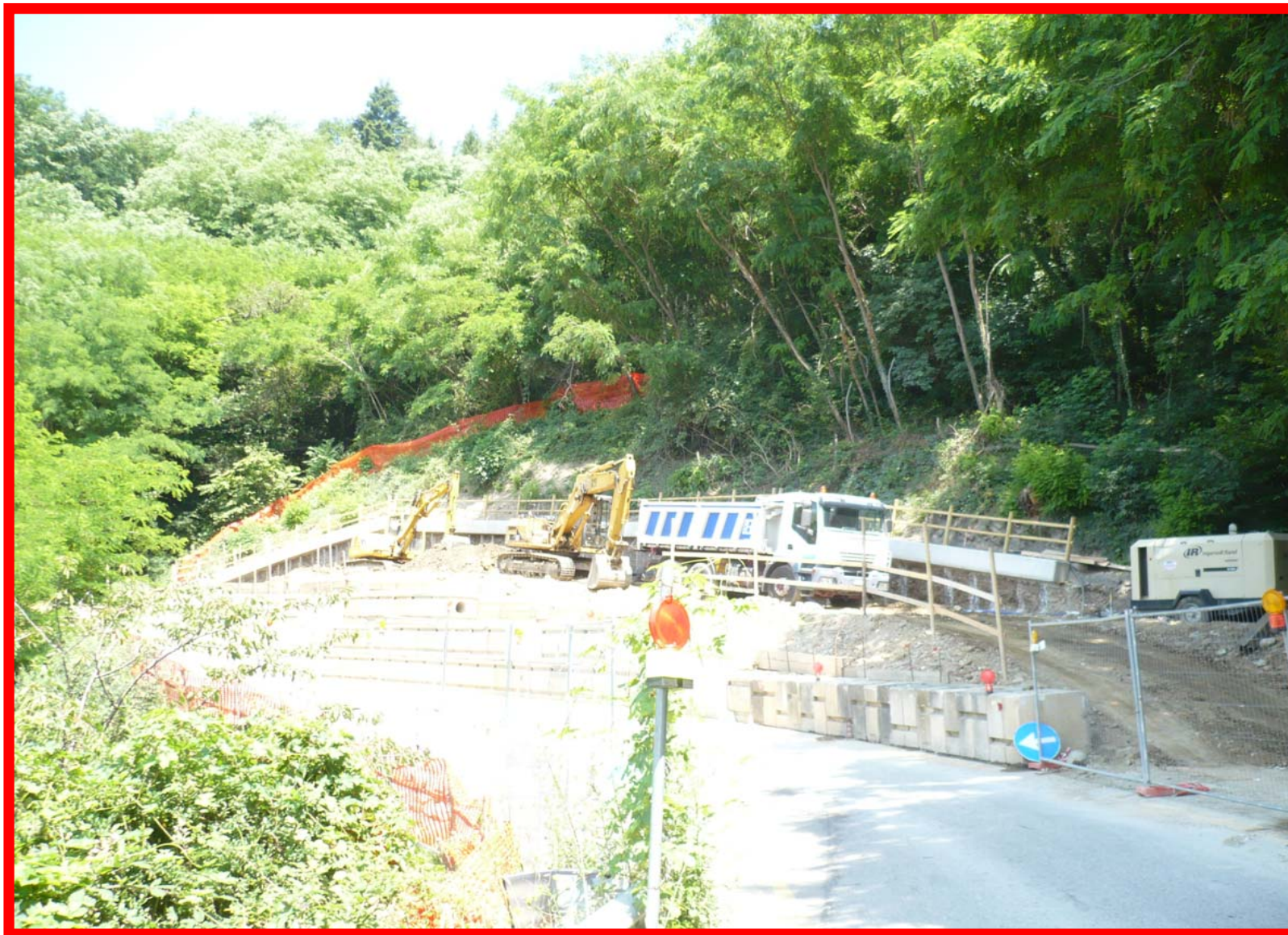
Abbassamento del I tratto della rampa
