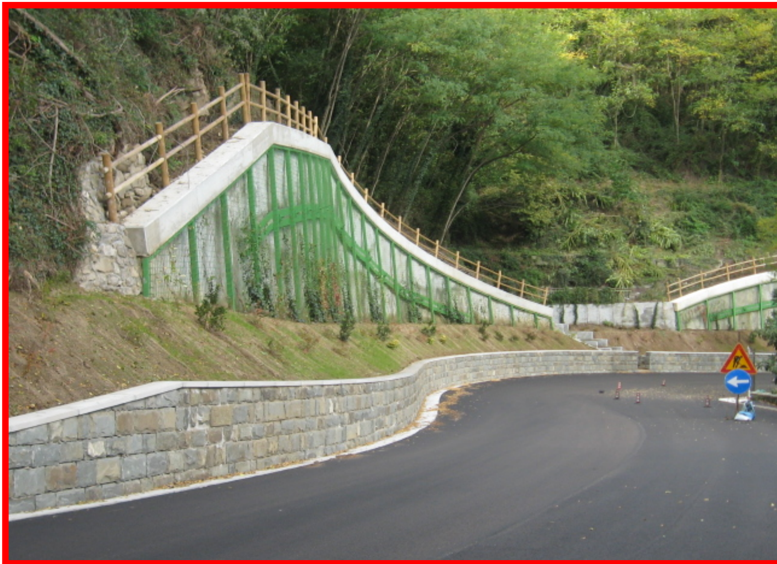
La sistemazione a verde della piccola scarpata al piede della berlinese – Pre disposizione dell'area di lavoro per la posa in opera della barriera di sicurezza
