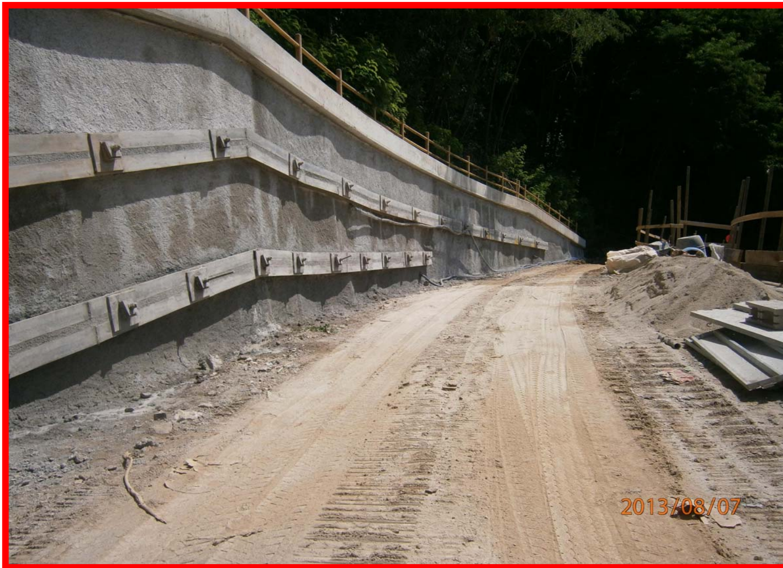
Lo spltz-beton eseguito sul I tratto della berlinese
