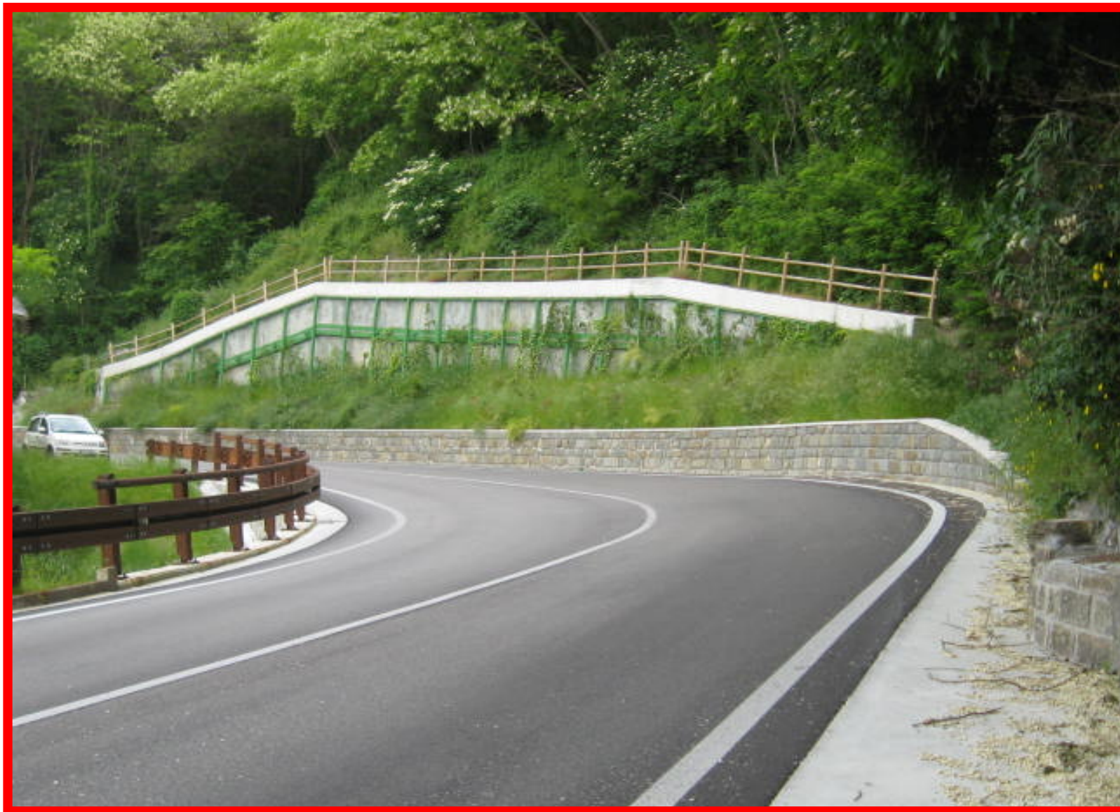
Il paramento di monte della berlinese del I tratto alla data del 19-05-2014
