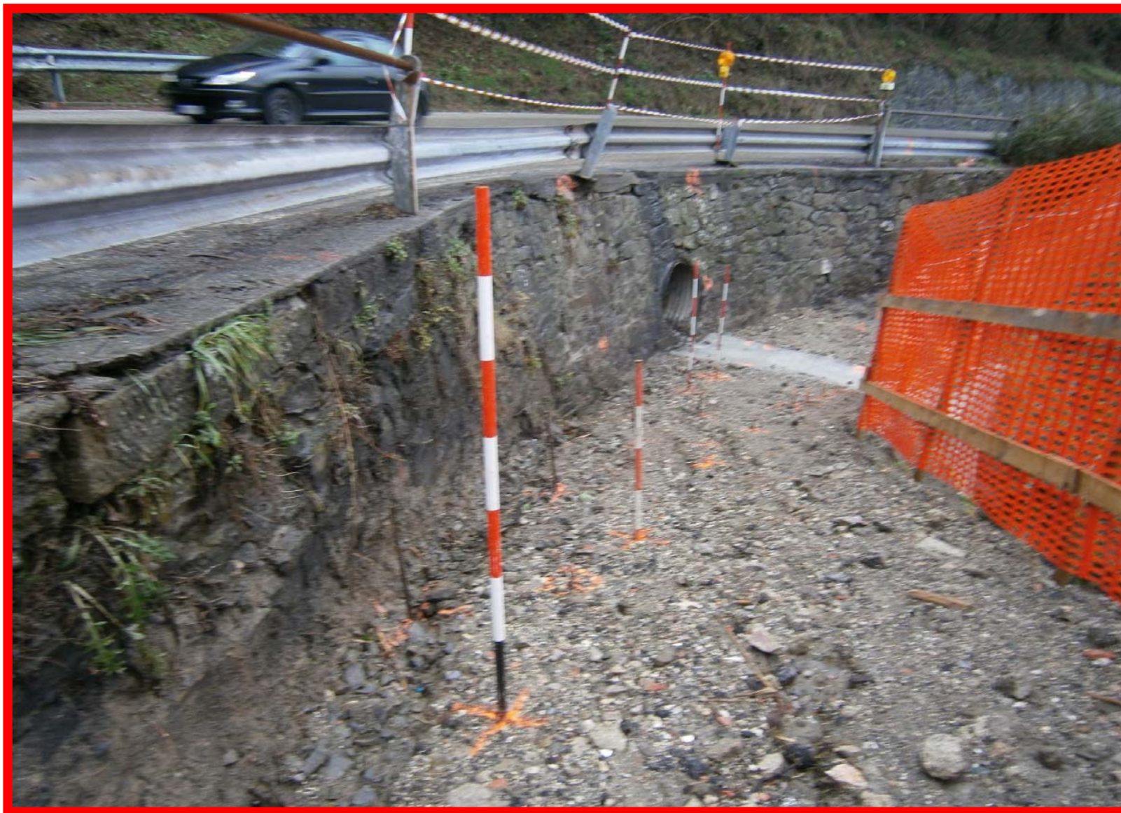
Area di lavoro a valle strada con le ubicazioni dei micropali da realizzare
