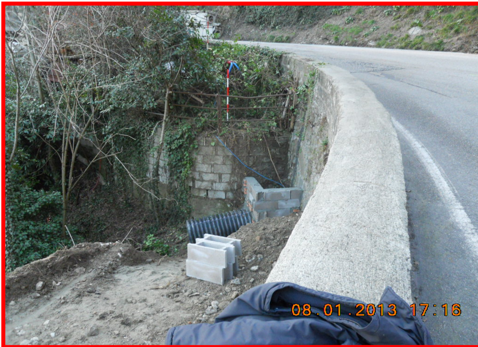
Vista dell'area di lavoro a valle strada verso Cireglio – Tombino in Ecopal
