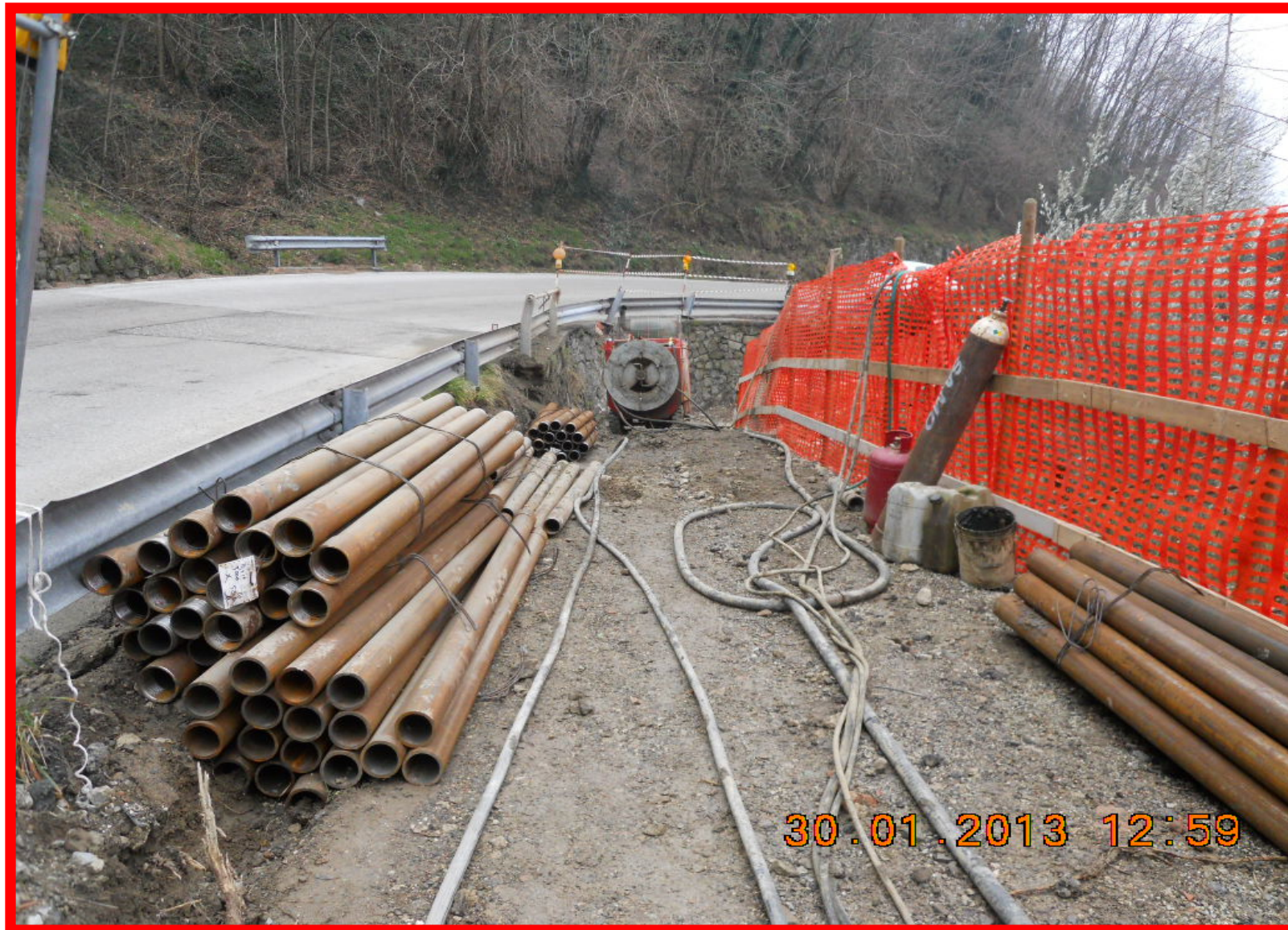
Le armature dei micropali accatastate nell'area di lavoro a valle strada
