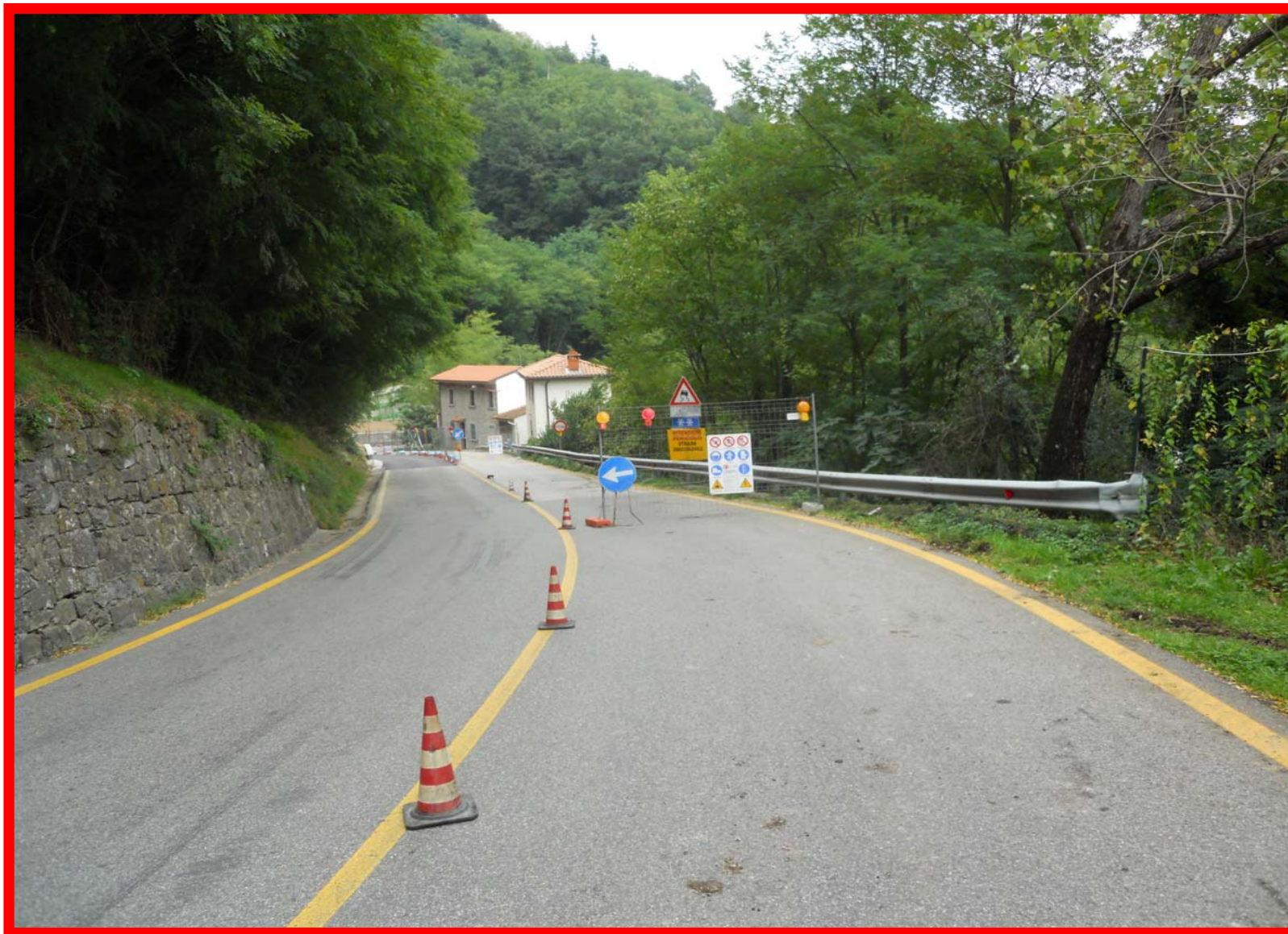
L'adattamento del cantiere stradale per i lavori di asfaltatura
