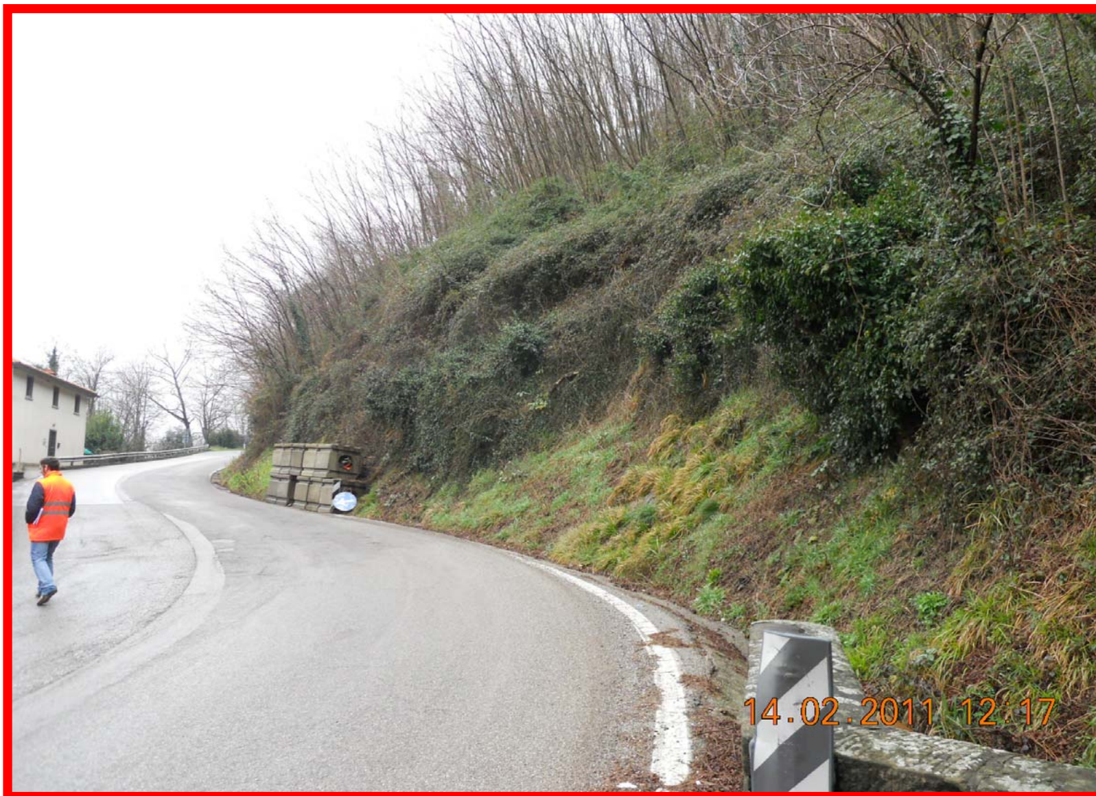
Vista del pendio adiacente alla prima curva verso Cireglio; notare la pendenza della scarpata di monte
