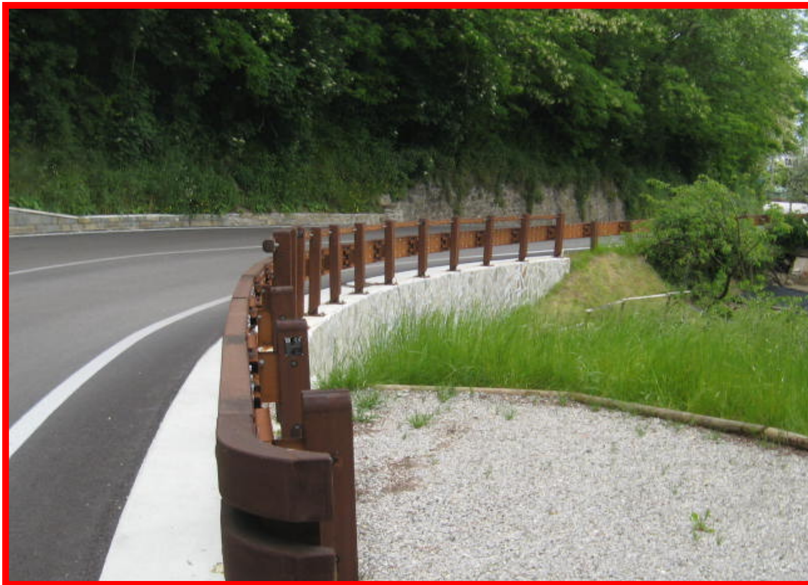
La seconda curva in loc. Tani – Particolare di valle alla data del 19-05-2014
