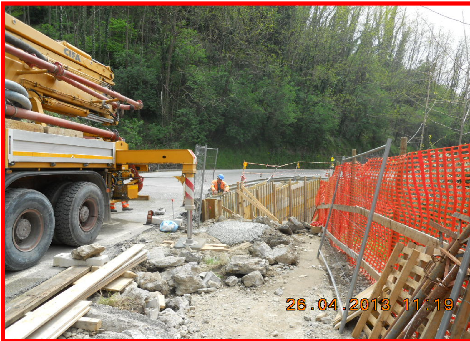
Getto di calcestruzzo con pompa per il muro lato valle
