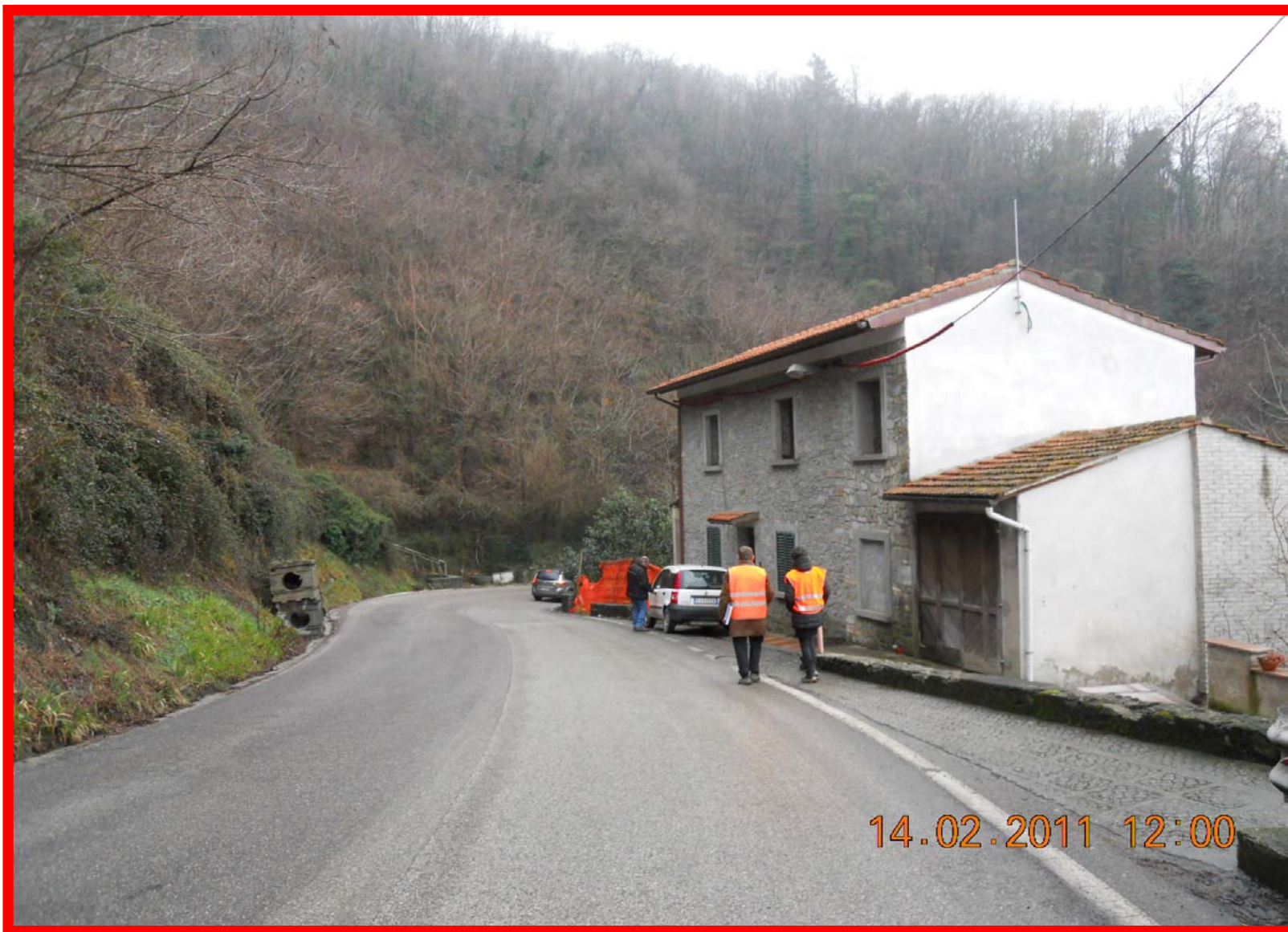
La foto precedente ma con vista ravvicinata; si noti il muro a gravità sulla SX
