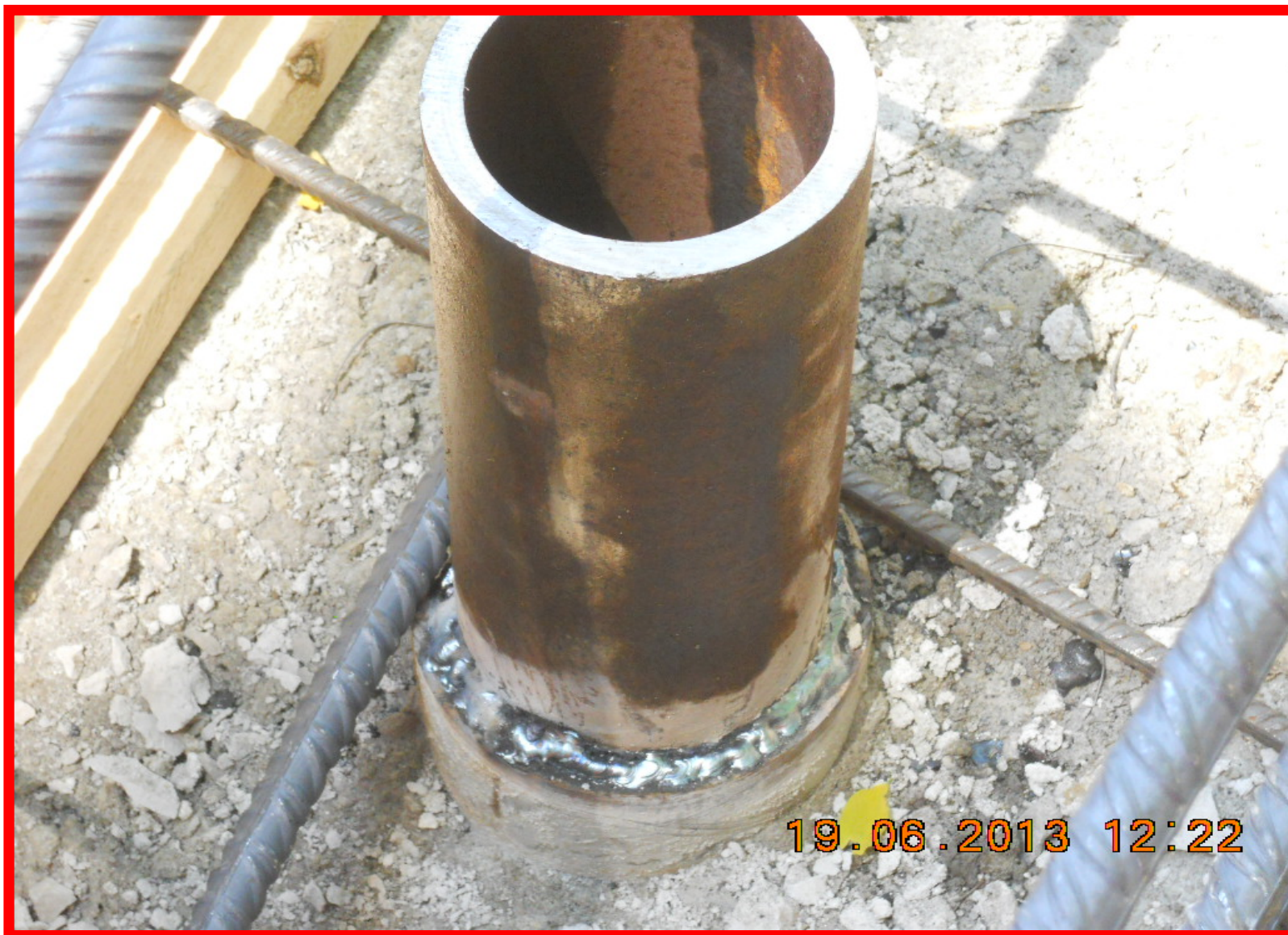
Particolare del prolungamento di armatura di un micropalo per immorsarlo meglio nel cordolo
