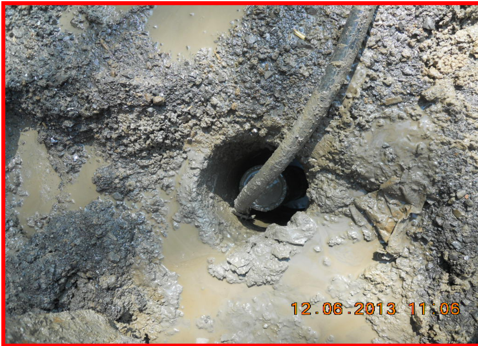
Il getto in pressione della boiaccia nel micropalo
