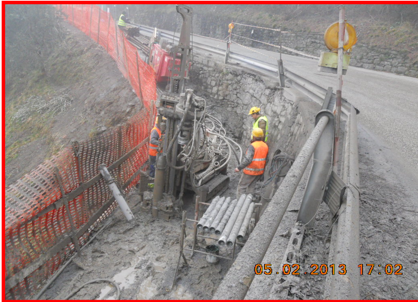
Vista dell'area di lavoro per la realizzazione della micropalificata (berlinese) a valle della strada
