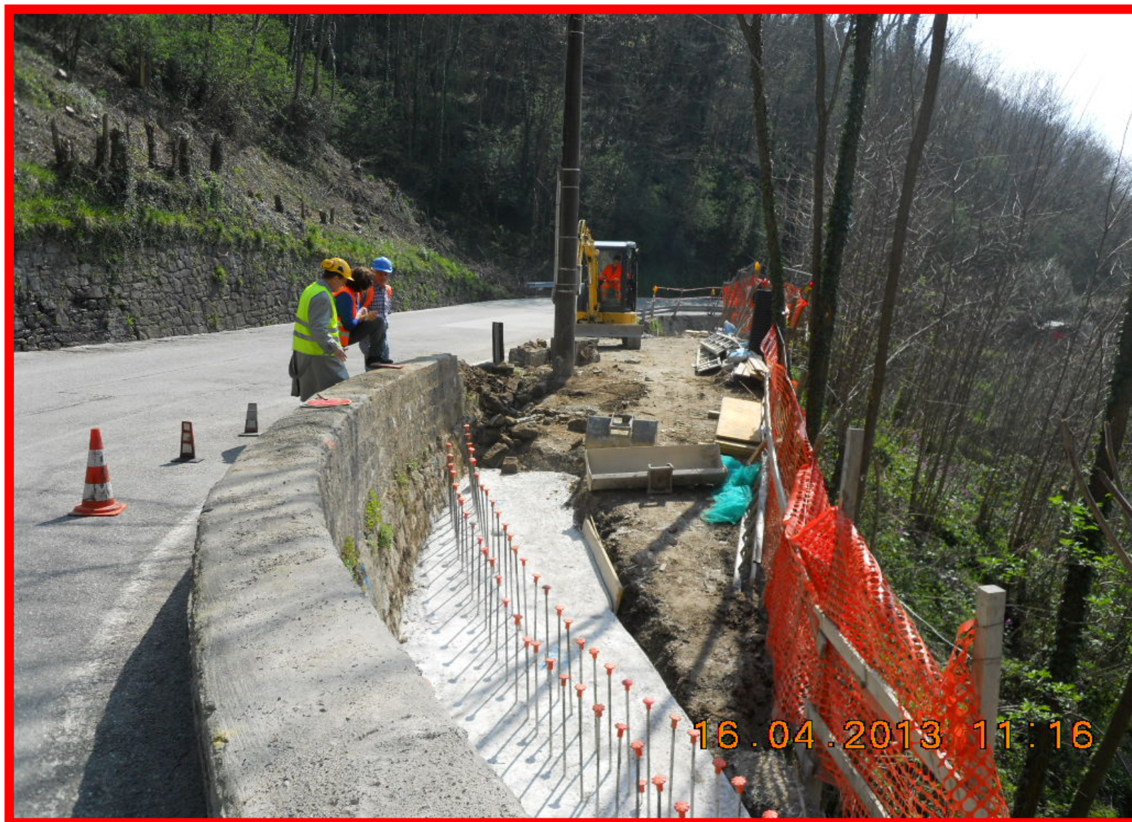
I ferri di ripresa della fondazione del muro a valle della strada
