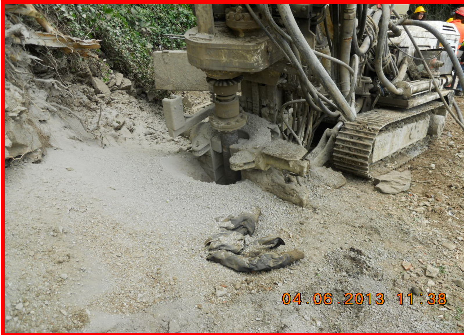
Particolare della trivella per lo scavo dei micropali
