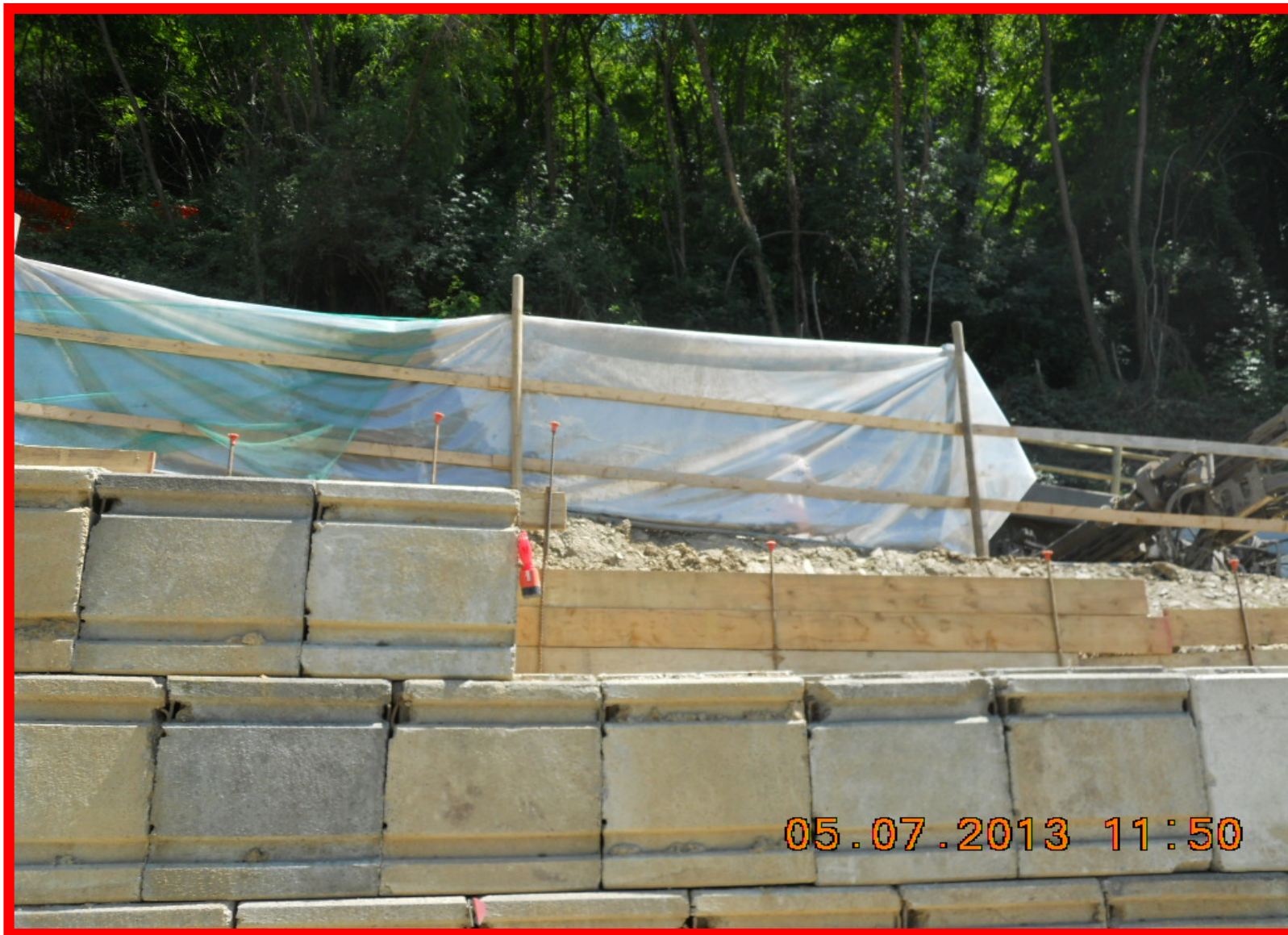
I teli antipolvere di protezione sulla sommità della rampa
