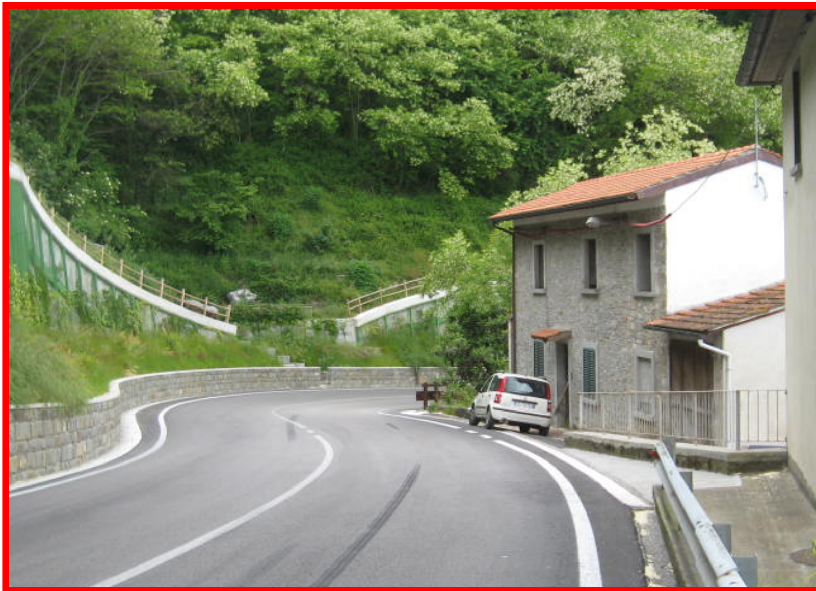
Particolare del II tratto della S.R.66-Pistoiese, loc. Tani alla data del 19-05-2014
