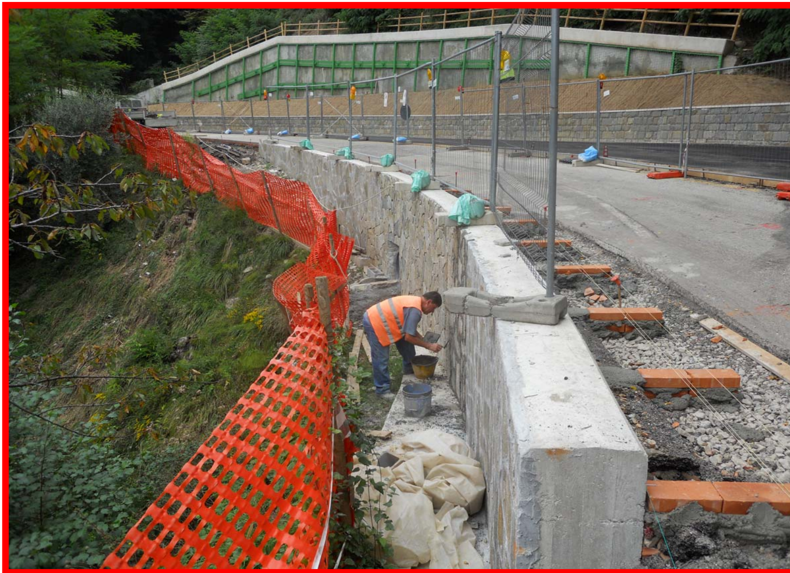
La stuccatura del rivestimento in pietrame del muro di sottoscarpa della 2 a curva verso Pistoia
