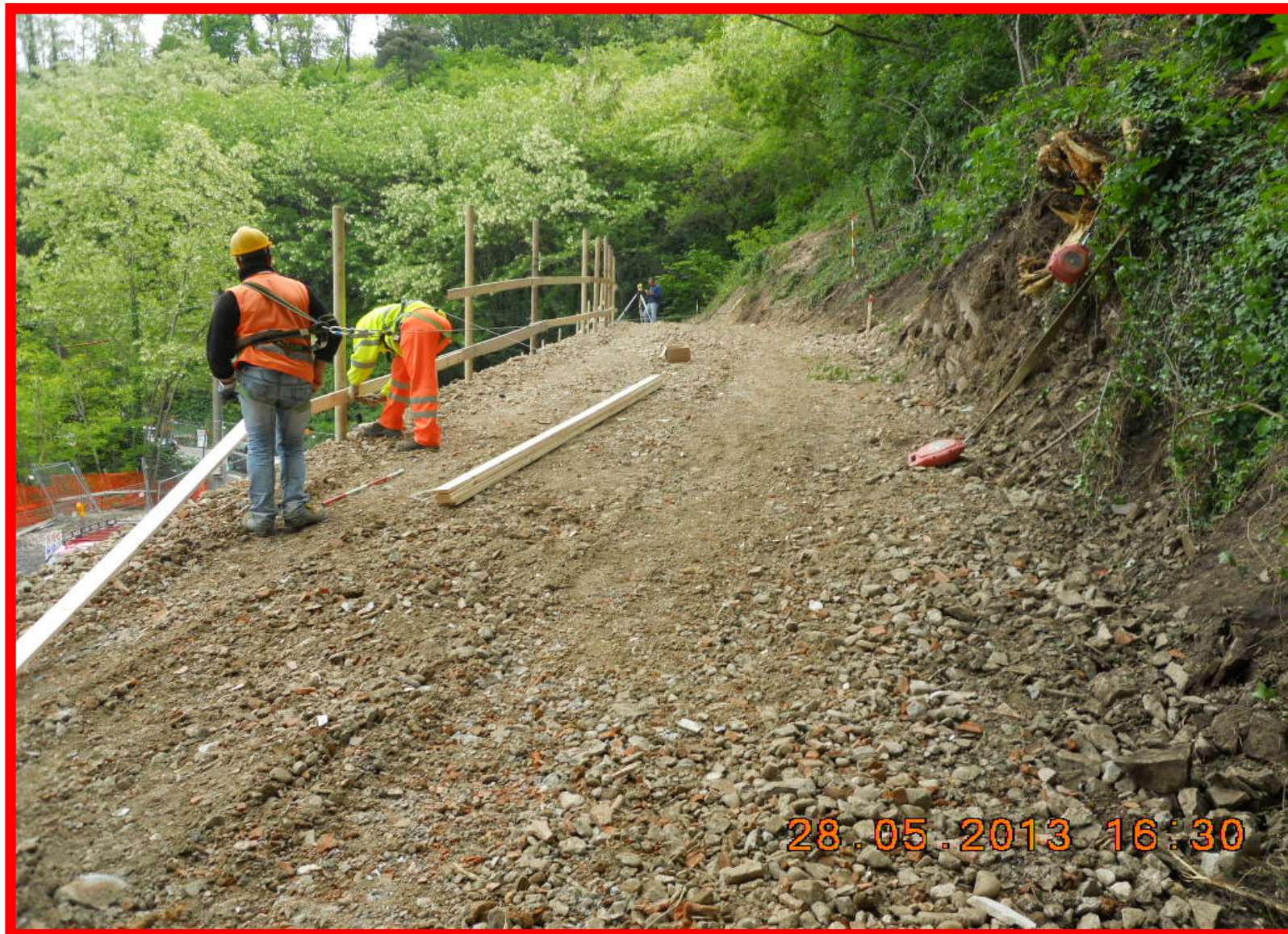
La realizzazione del parapetto sulla sommità della rampa – Notare gli operai con la linea-vita
