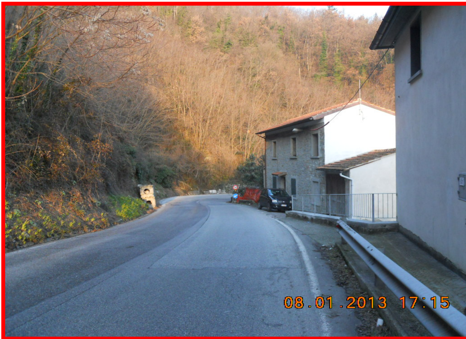
Vista della curva verso Pistoia prima dell'intervento - A dx si notano i cartelli stradali di indicazione del cantiere
