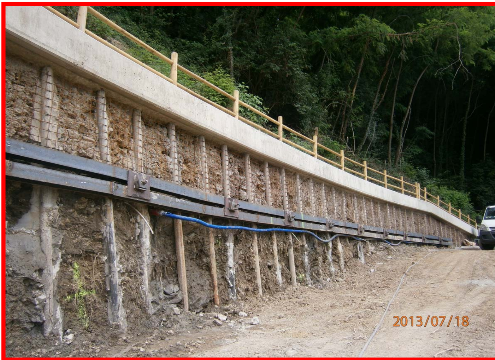
Armatura di collegamento delle teste dei tiranti
