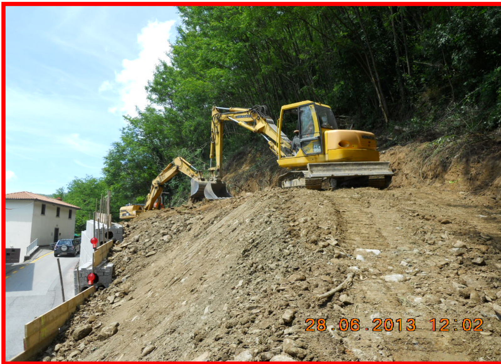
Costruzione del II tratto della rampa verso Cireglio
