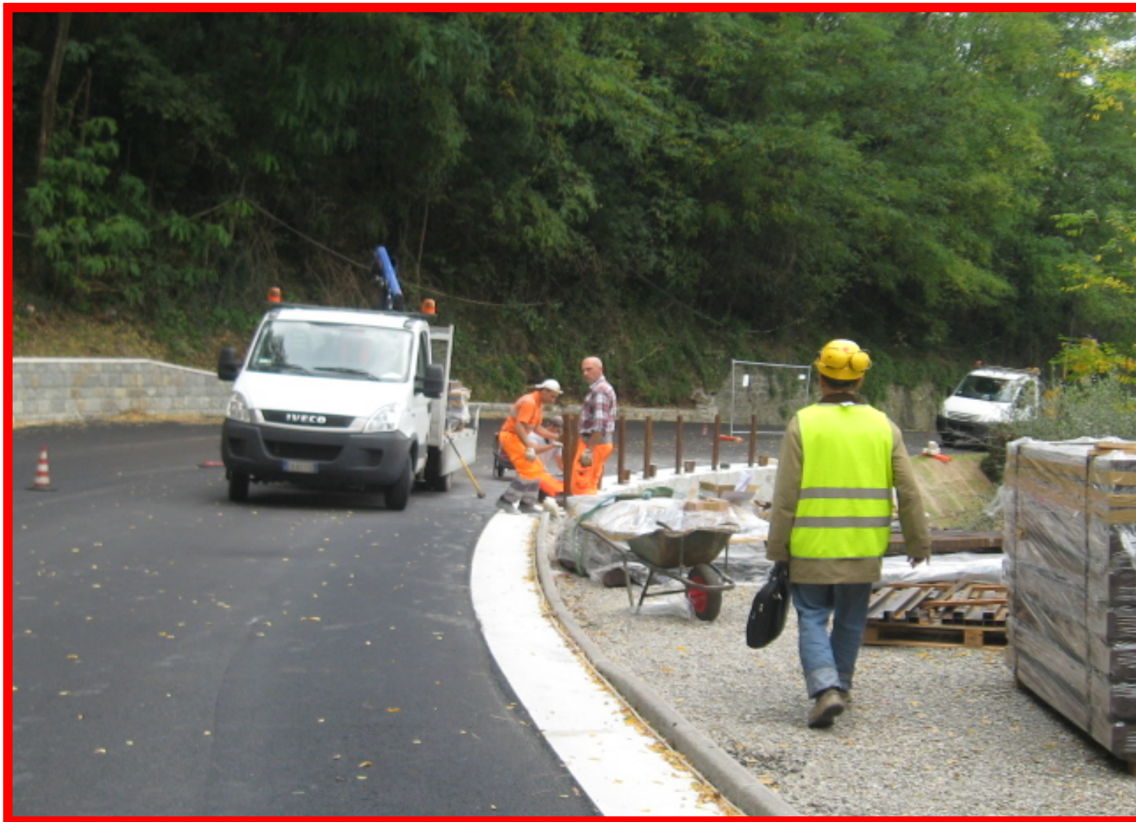
La messa in opera della barriera di sicurezza
