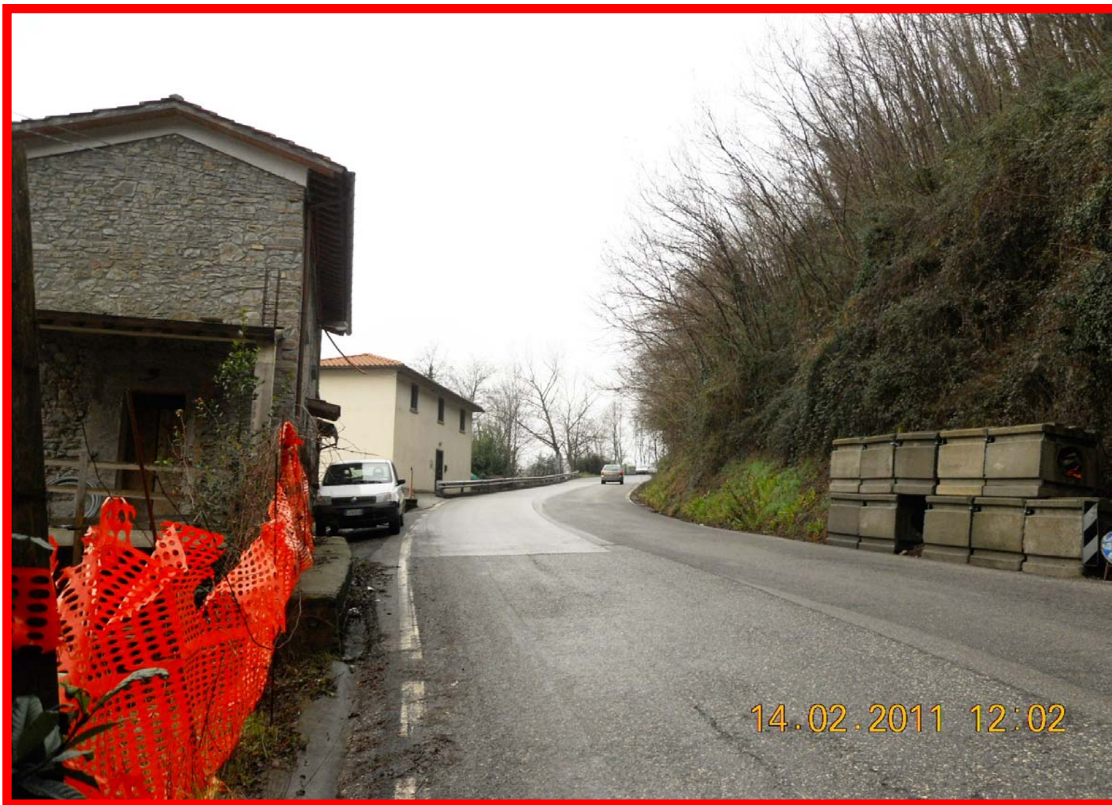
Vista della carreggiata stradale dalla curva verso Cireglio
