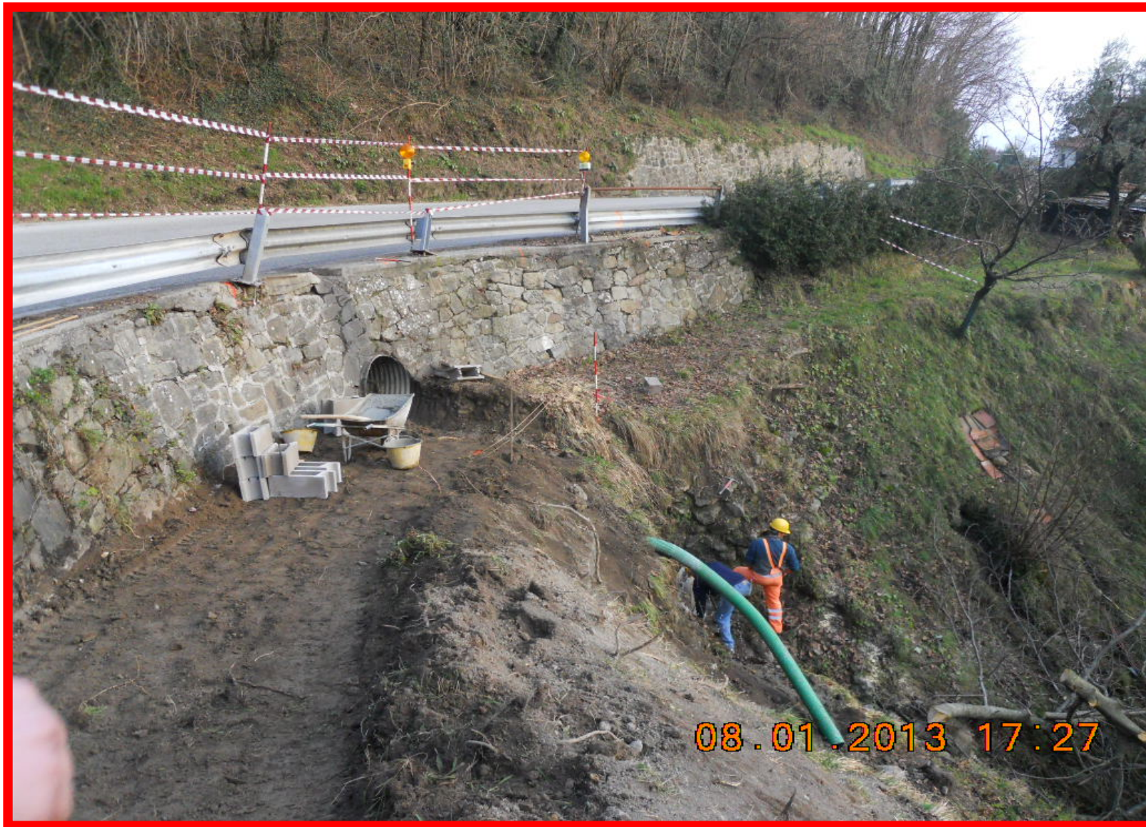
Vista area di lavoro della 2 a curva a valle strada verso Pistoia – Predisposizione sgrondo acque
