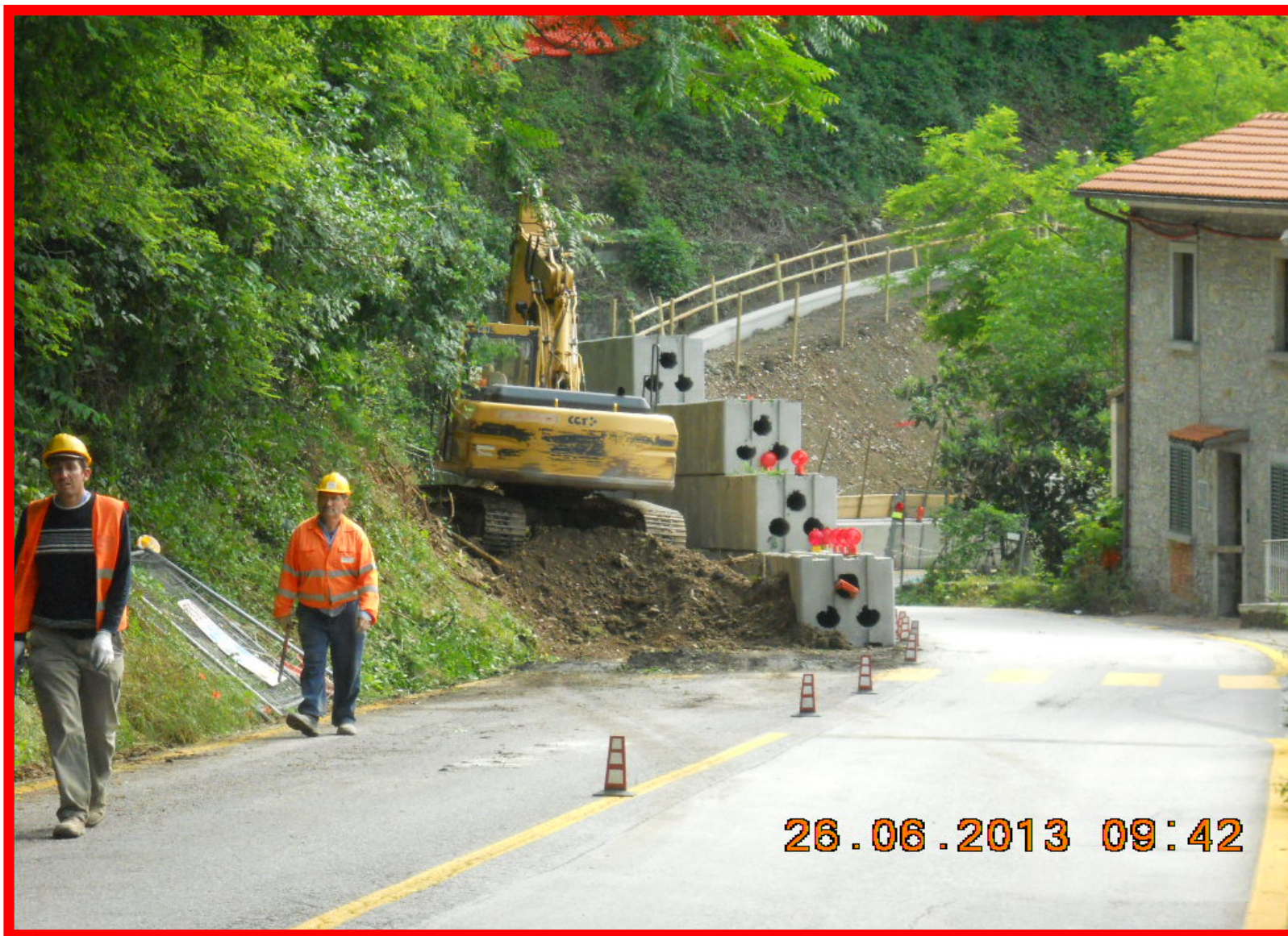
Vista della berlinese del I tratto con già realizzato il cordolo di sommità
