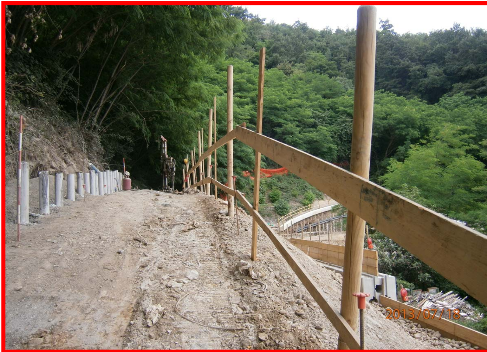
Costruzione del II tratto della berlinese
