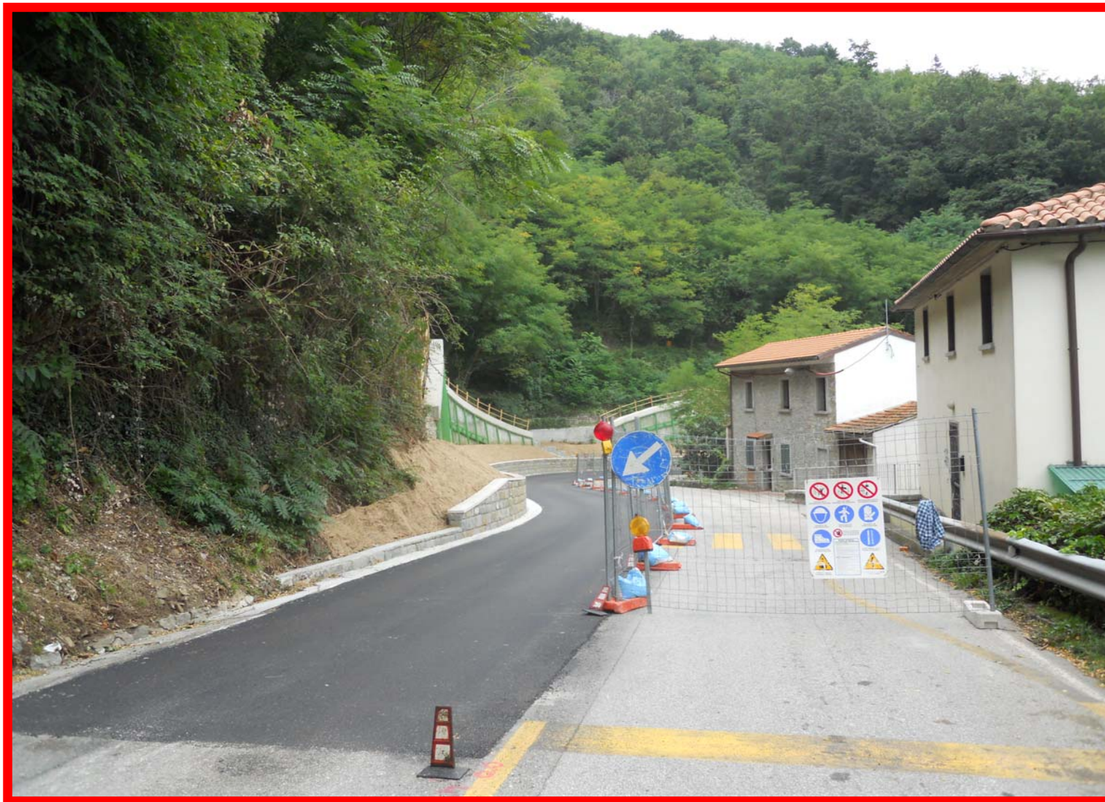
L'asfaltatura di una delle due corsie di marcia – Notare la delimitazione dell'area di lavoro
