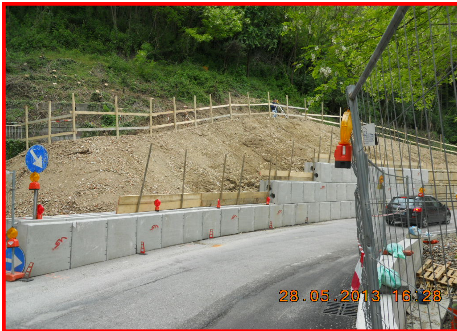
Il prolungamento della rampa a monte della strada
