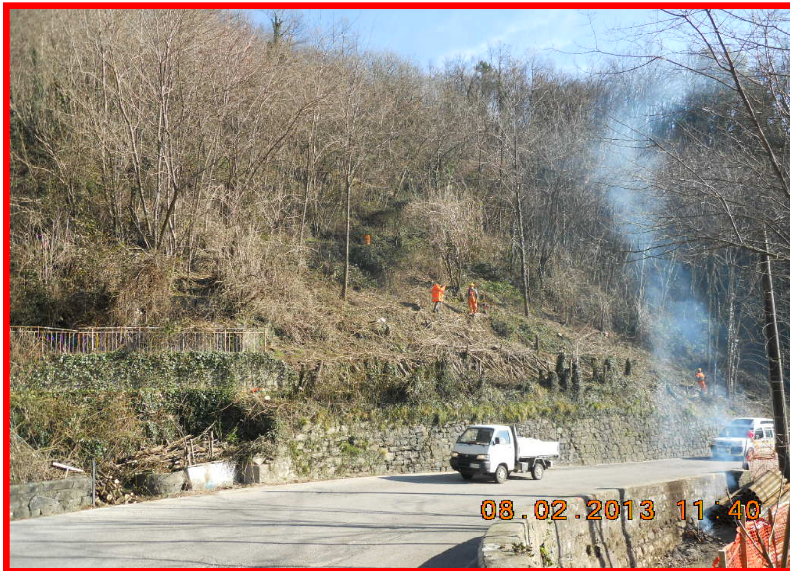
Il taglio della vegetazione sulla scarpata a monte
