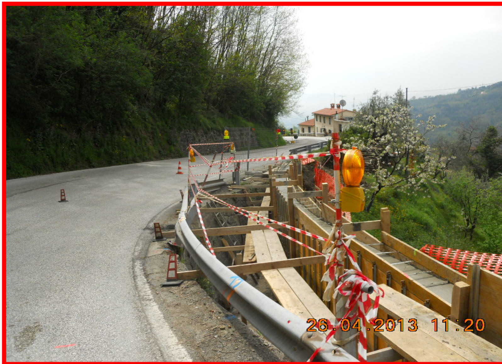
Il getto del muro sul lato valle – Notare l'allargamento della carreggiata stradale
