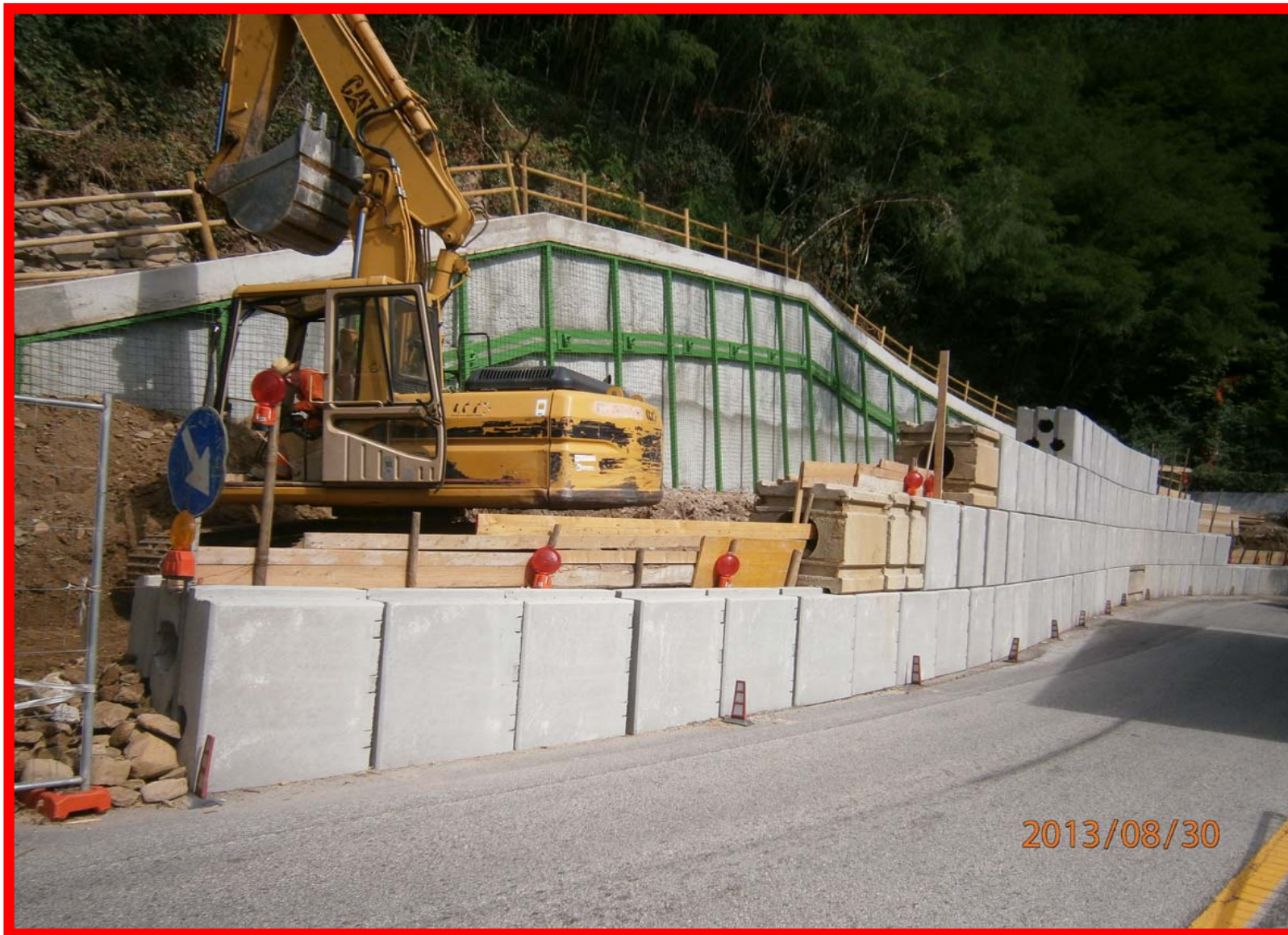
Abbassamento del II tratto della rampa
