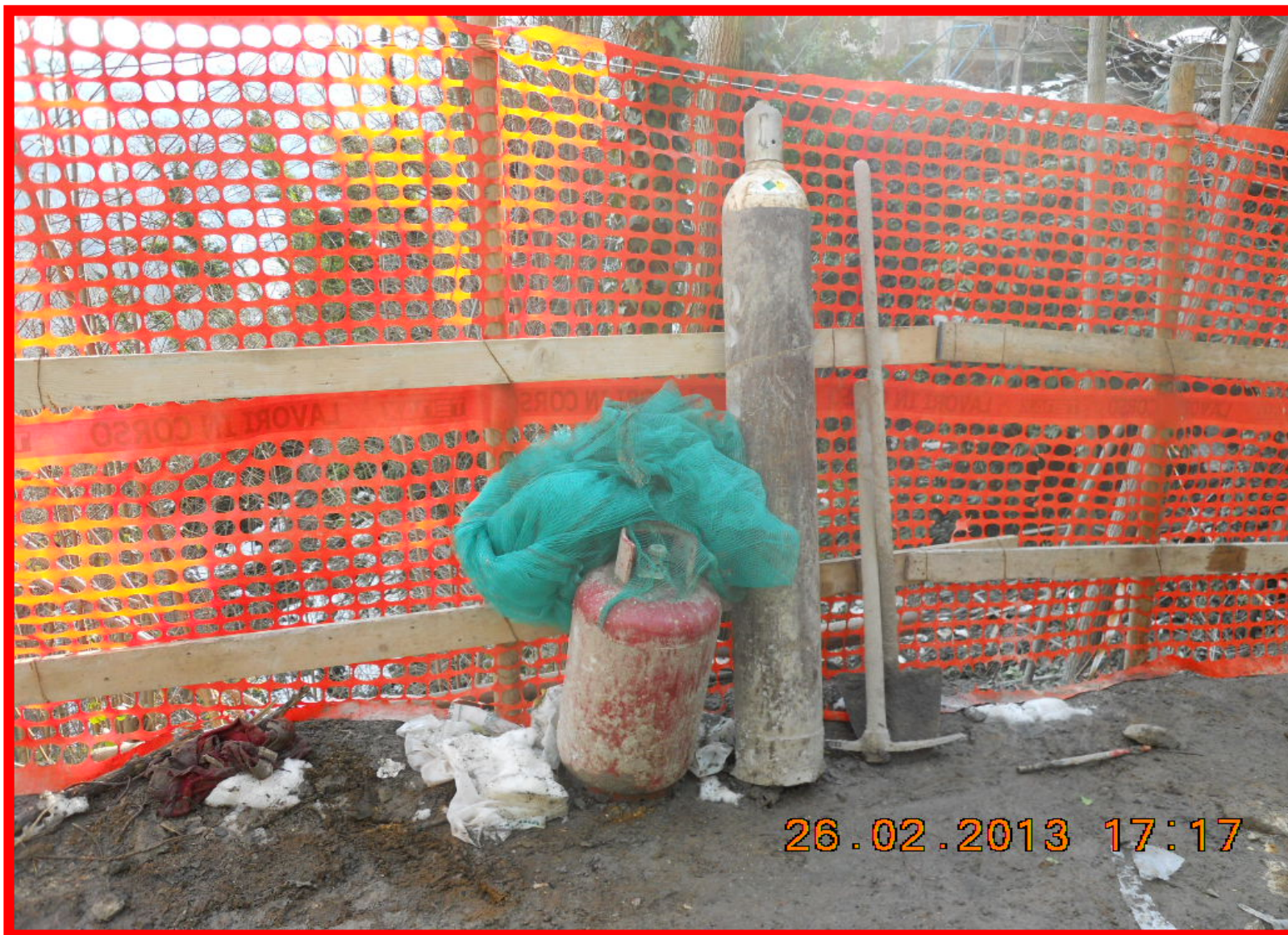
Il deposito incustodito delle bombole usate per la costruzione dei micropali
