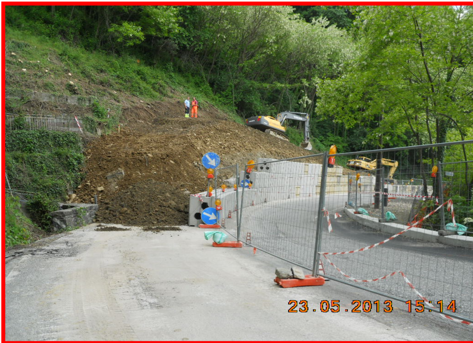
La costruzione del I tratto della rampa sul lato a monte della strada
