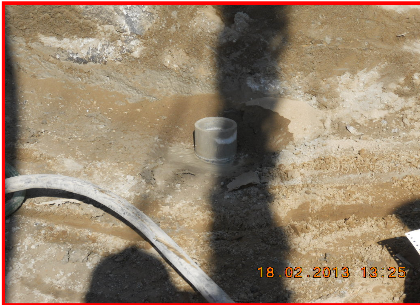
L'armatura metallica del micropalo inserita nello scavo e riempita di boiacca
