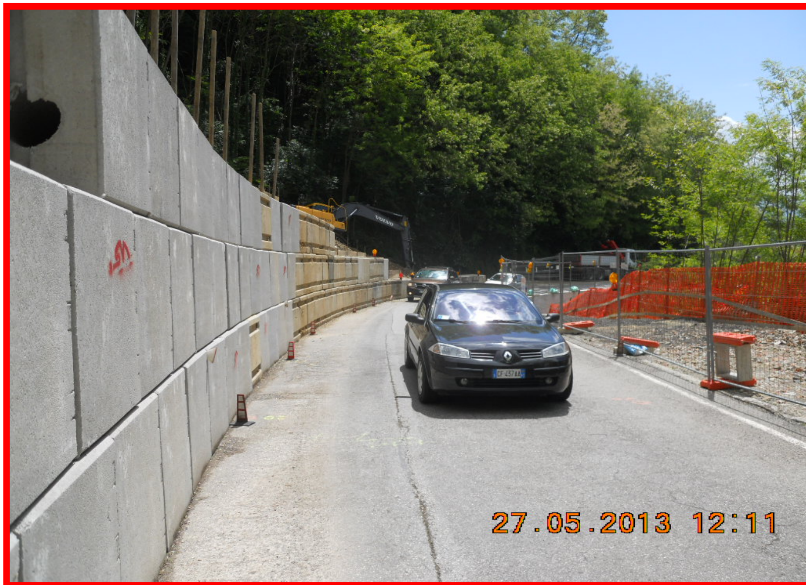
La carreggiata stradale a senso unico alternato regolato da impianto semaforico
