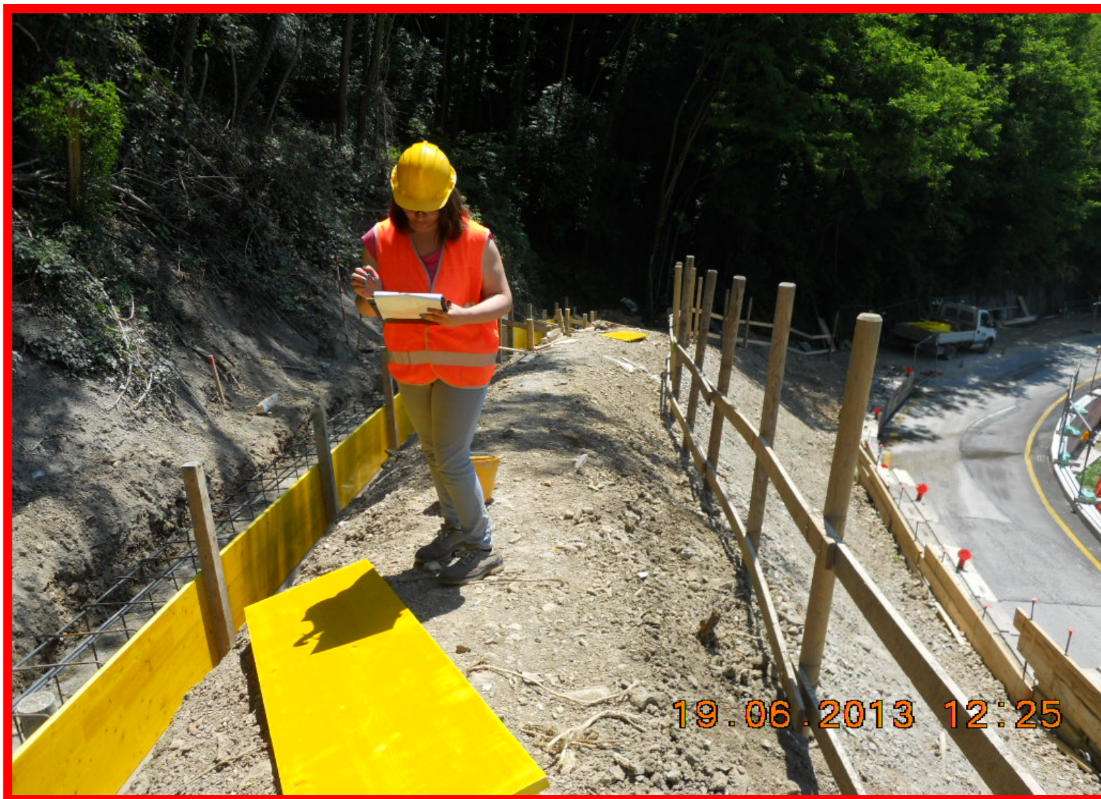
Predisposizione della casseratura del cordolo in c.a.
