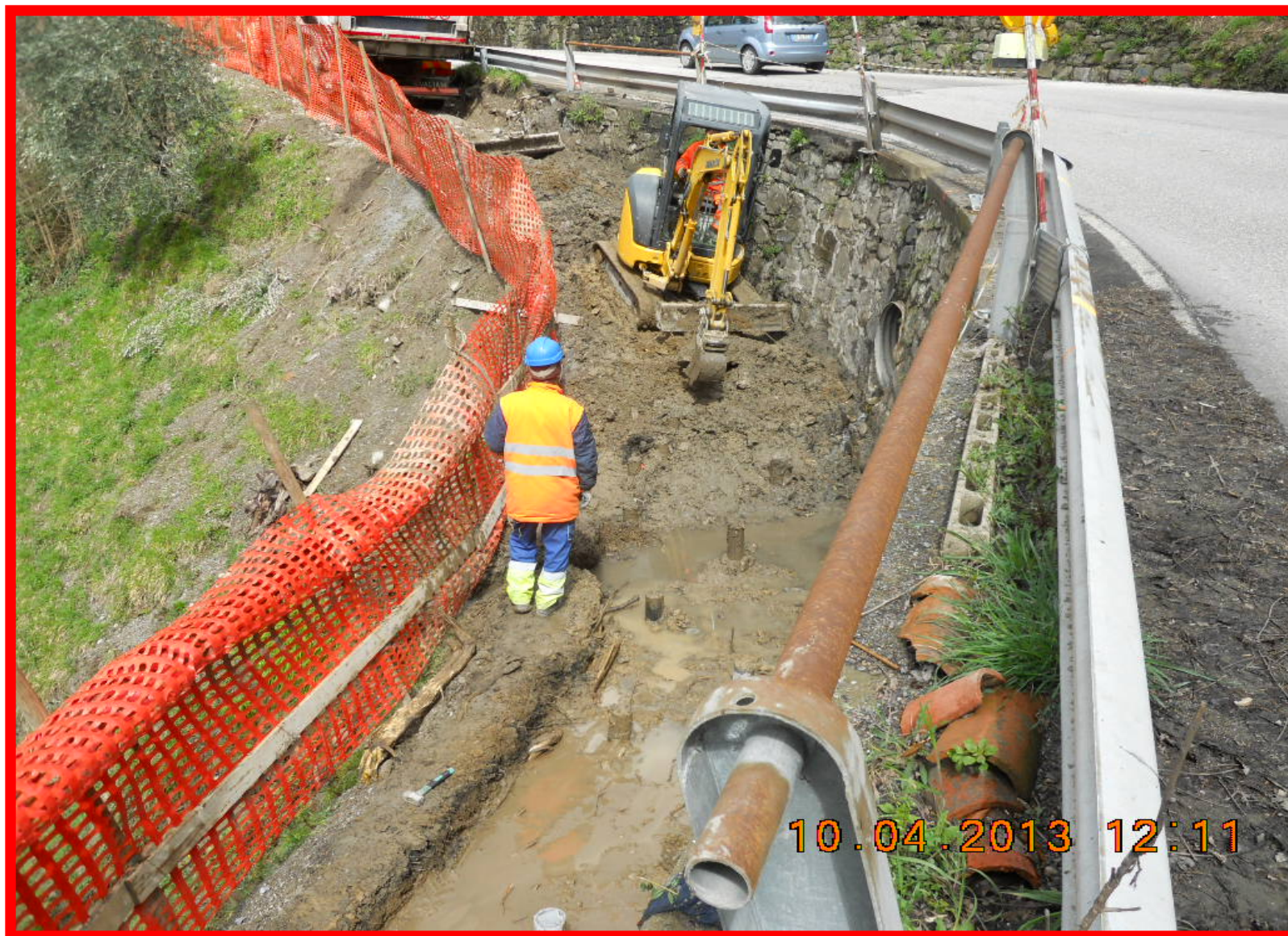
Vista dell'area di lavoro con lo scavo della fondazione del muro
