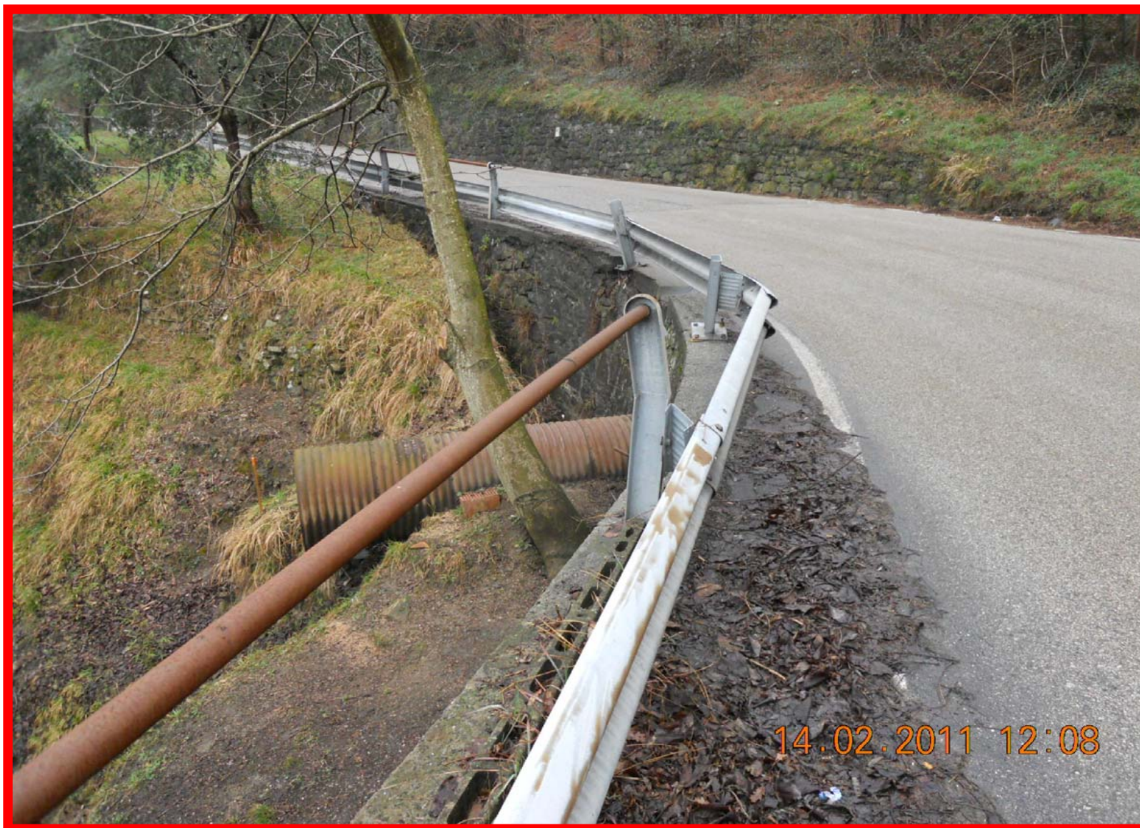
Particolare della seconda curva verso Cireglio con la barriera di Sicurezza che, a seguito di urti, aveva formato una cuspide pericolosa
