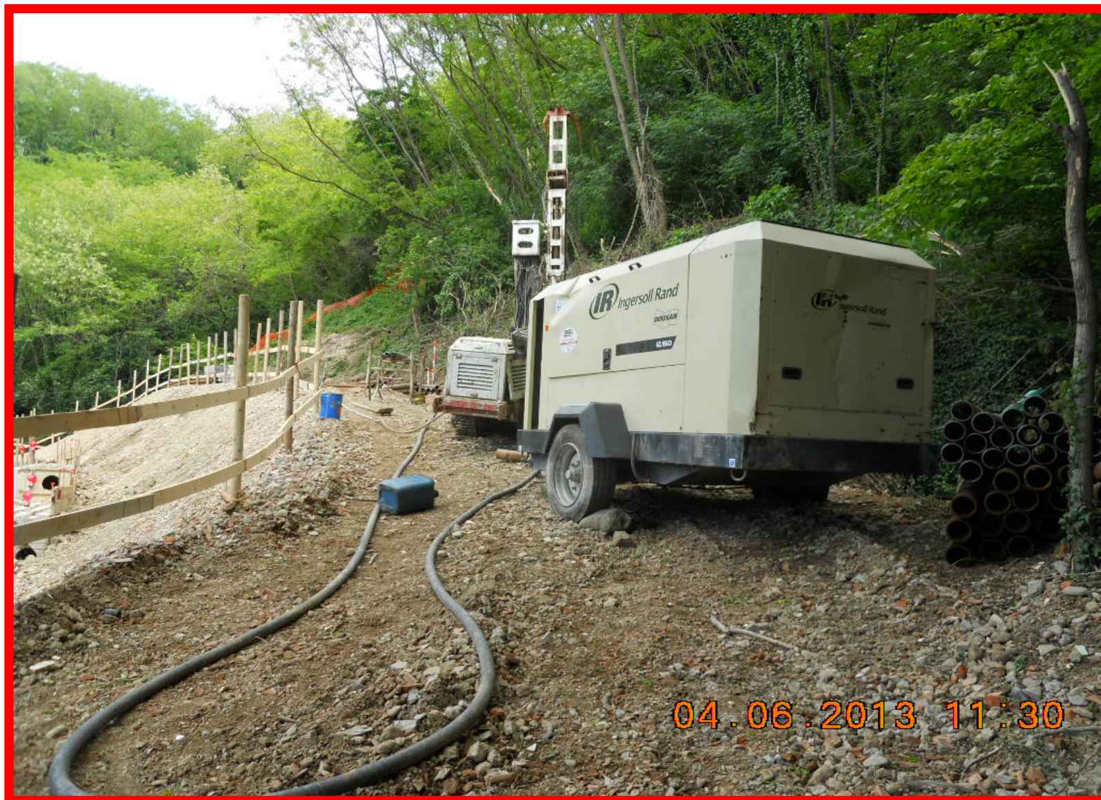
Particolare del I tratto della rampa con il compressore che alimenta la macchina operatrice dei micropali
