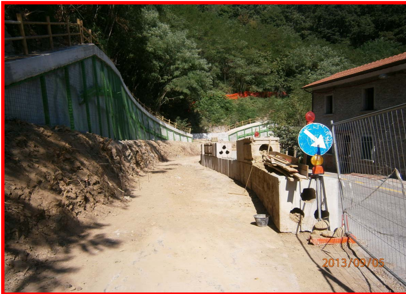
Lo smontaggio completo del II tratto della rampa
