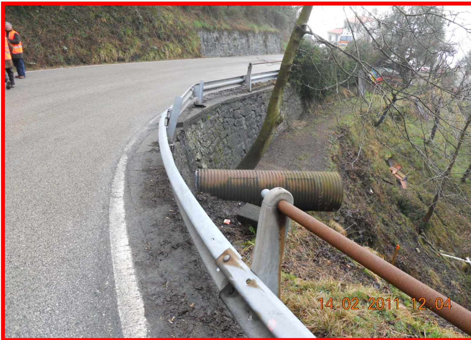
Vista della barriera di sicurezza oggetto di urti a seguito di incidenti
