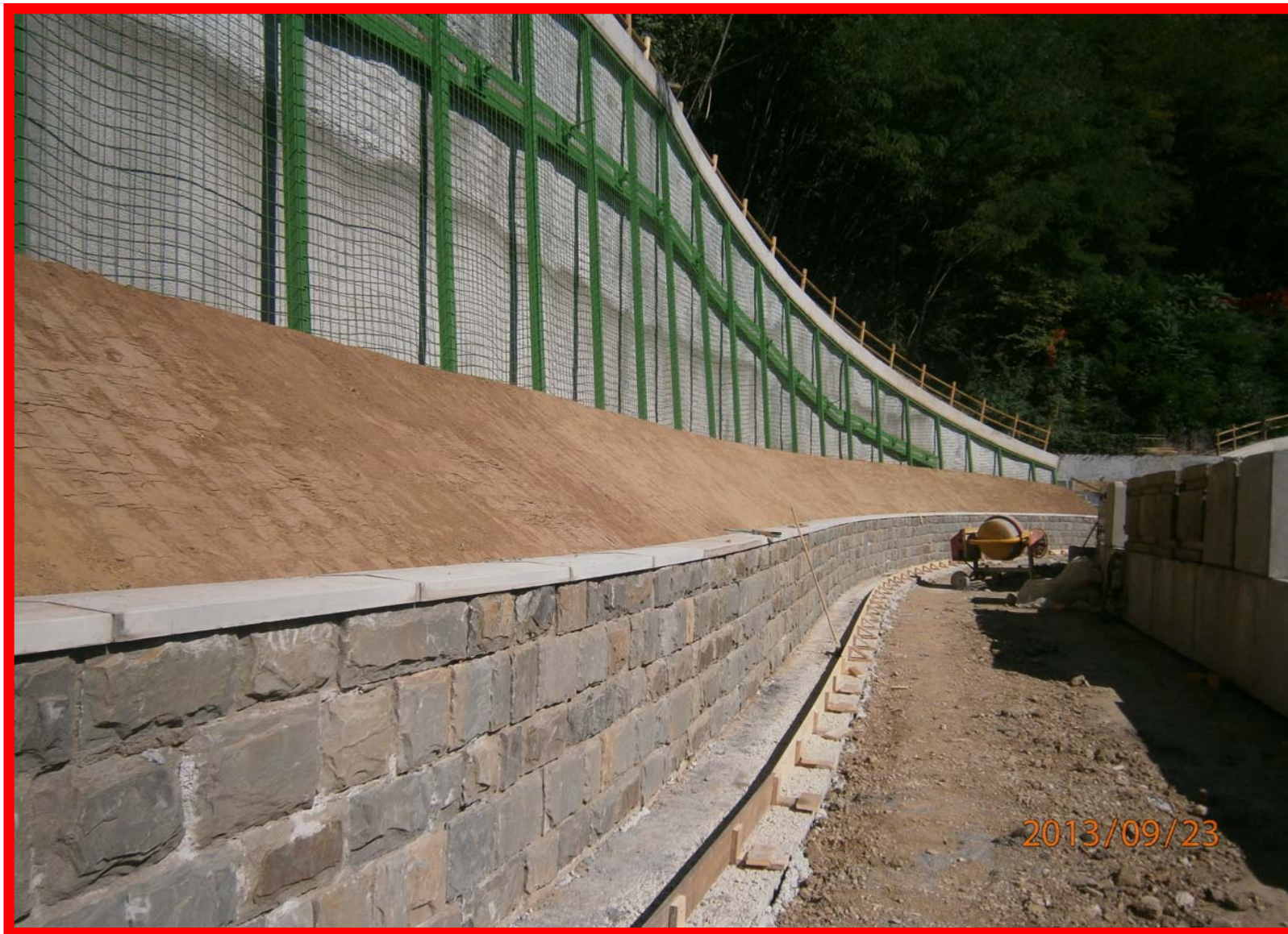
Il muretto di contenimento a lastre prefabbricate
