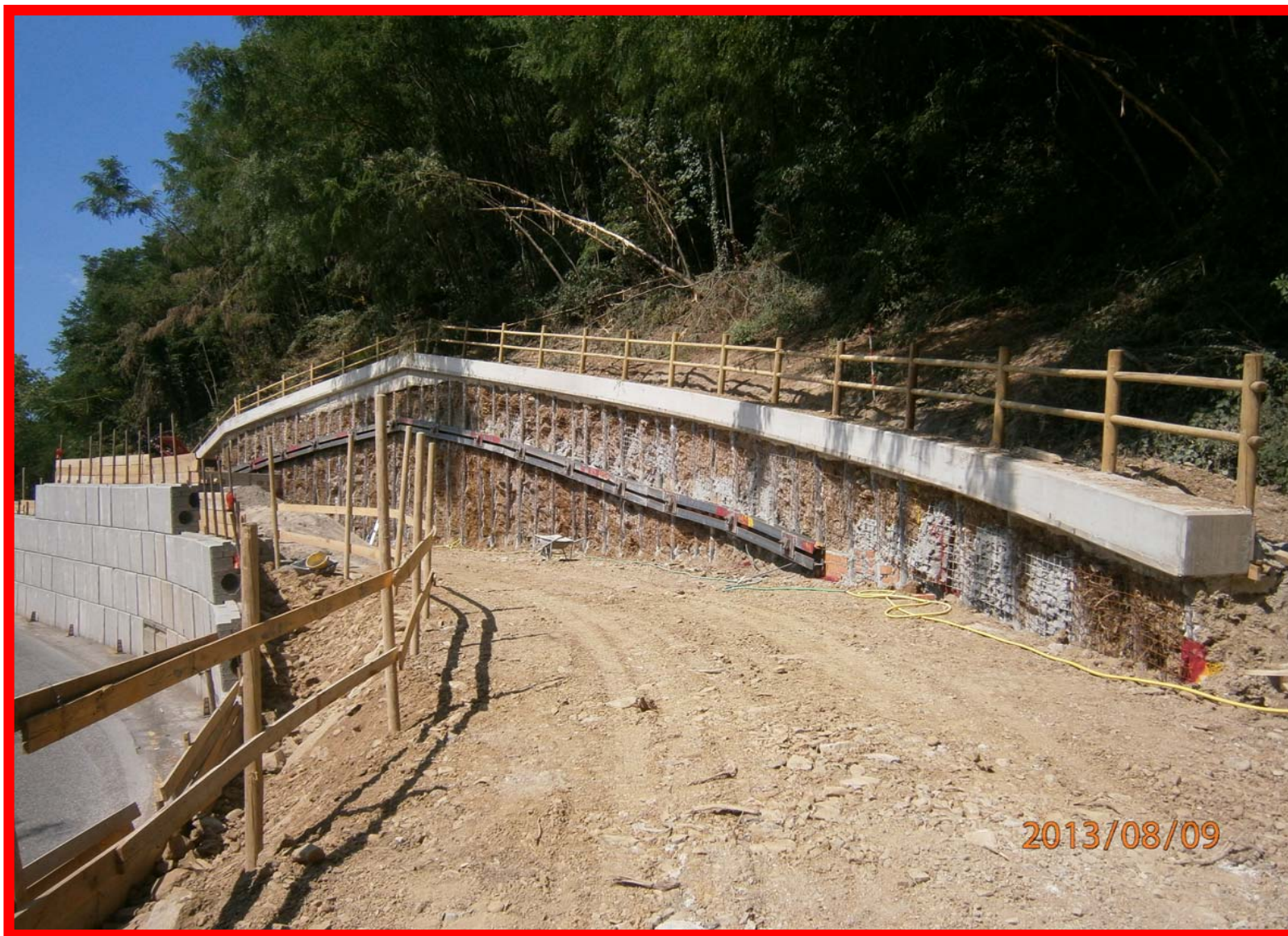
L'abbassamento del II tratto della rampa e l'armatura delle teste dei tiranti
