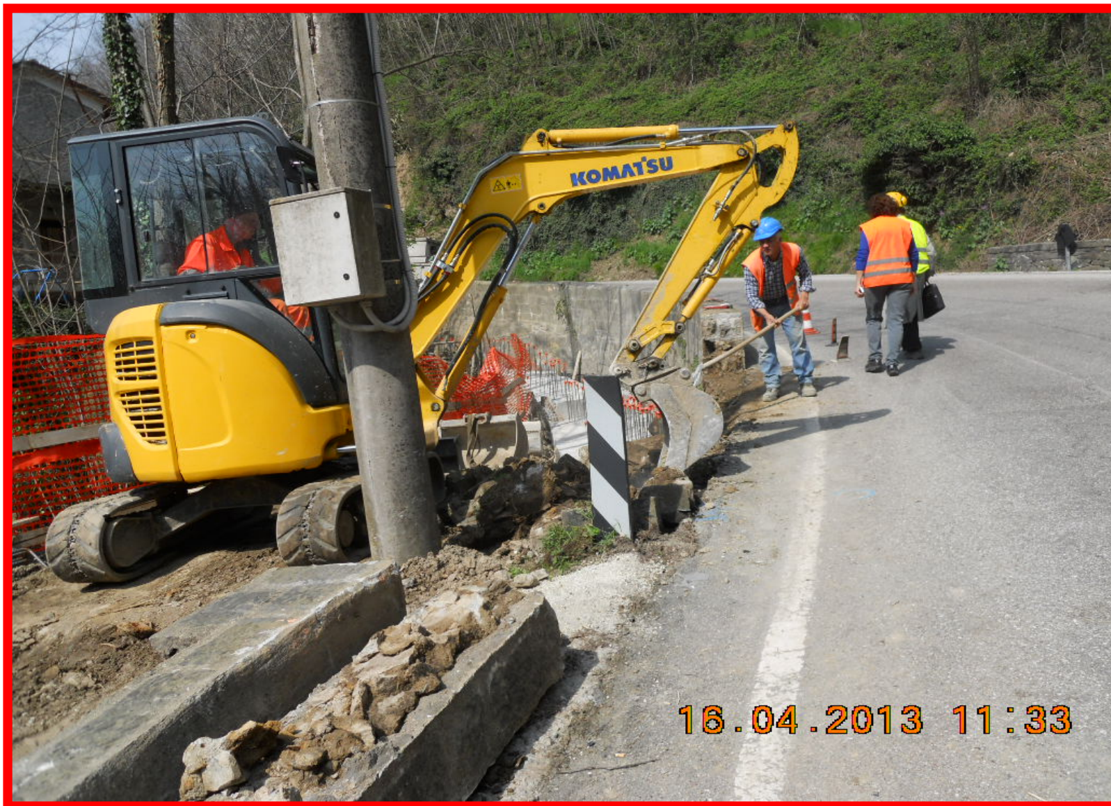
La demolizione del parapetto a valle strada
