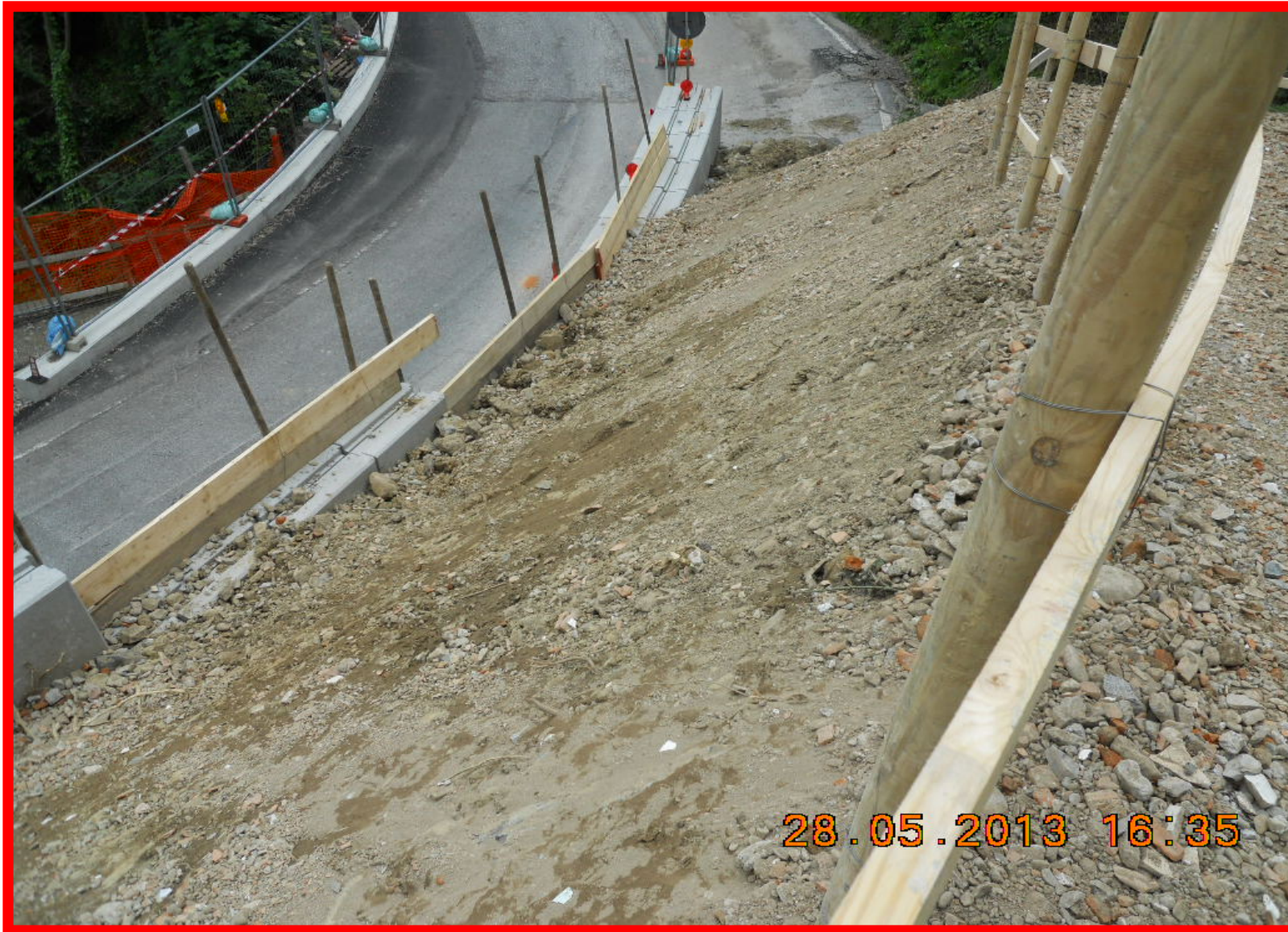
Particolare della scarpata del I tratto della rampa provvisoria
