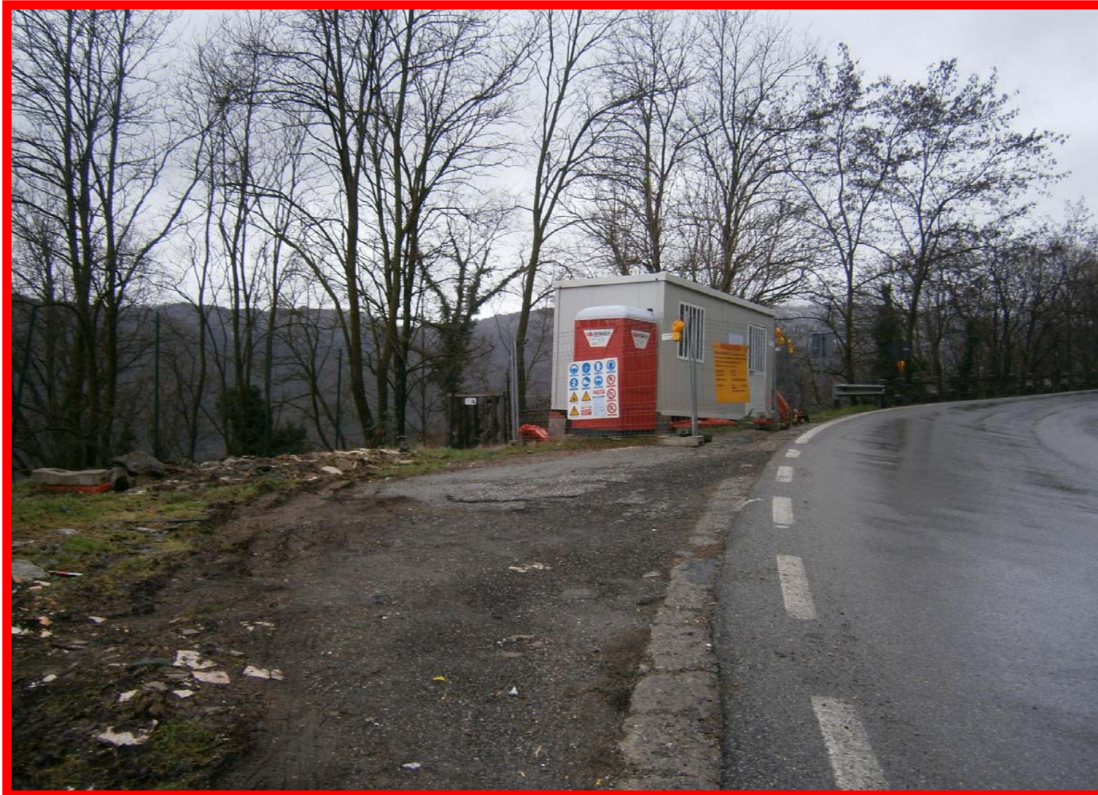
Il cantiere con i baraccamenti
