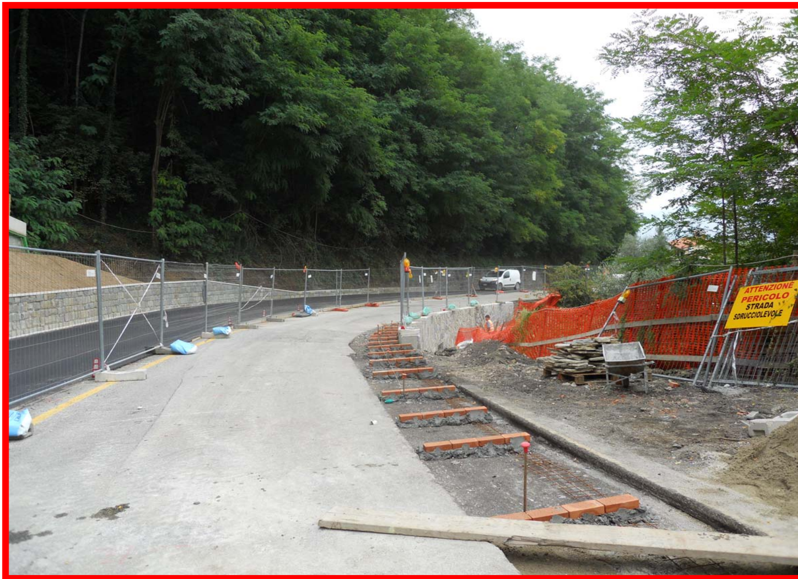
La costruzione della zanella sul lato a valle della carreggiata
