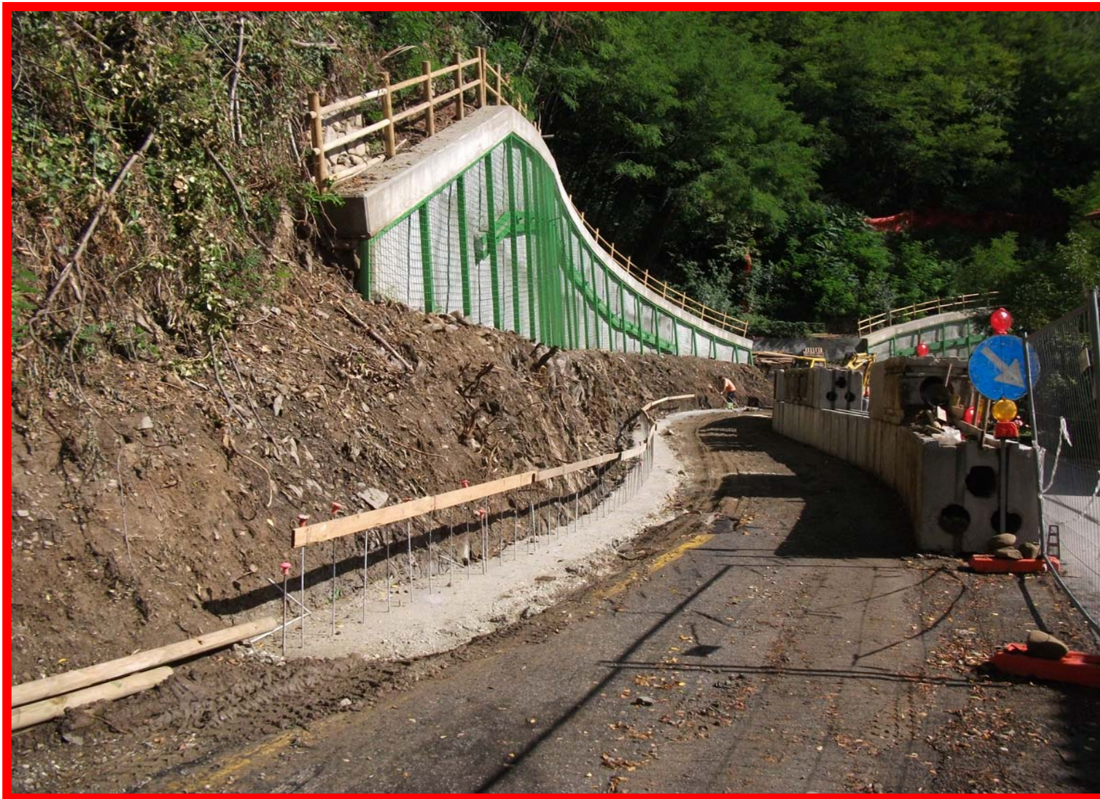
La fondazione del muretto di contenimento al piede della berlinese
