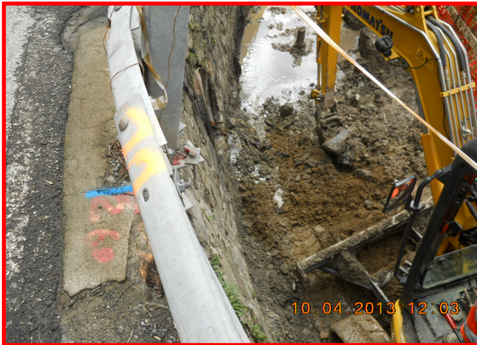
Lo scavo di fondazione del muro attestato sui micropali dalla parte a valle
