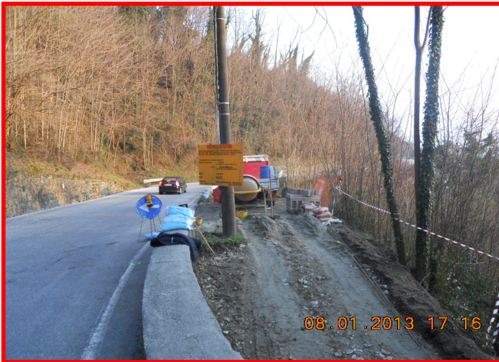
Area di lavoro in allestimento a valle dell'S.R.66-Pistoiese – Vista verso Pistoia
