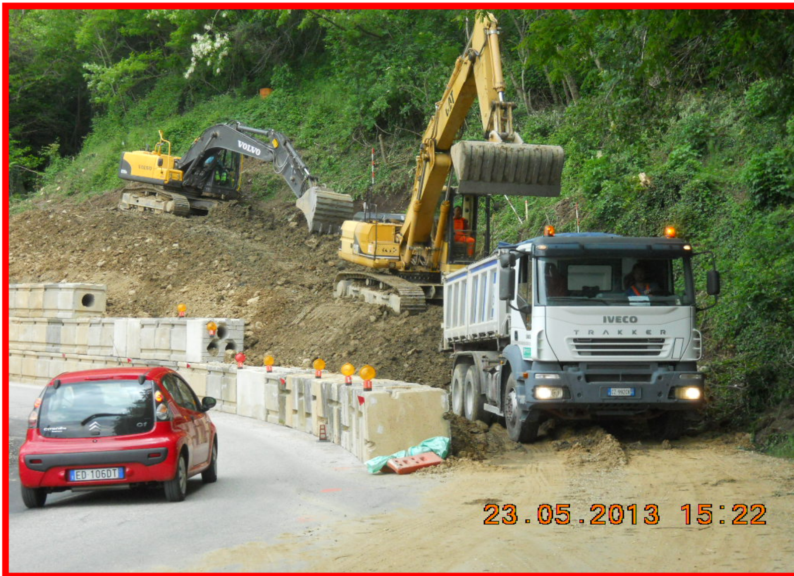
Vista degli escavatori utilizzati per la costruzione della rampa
